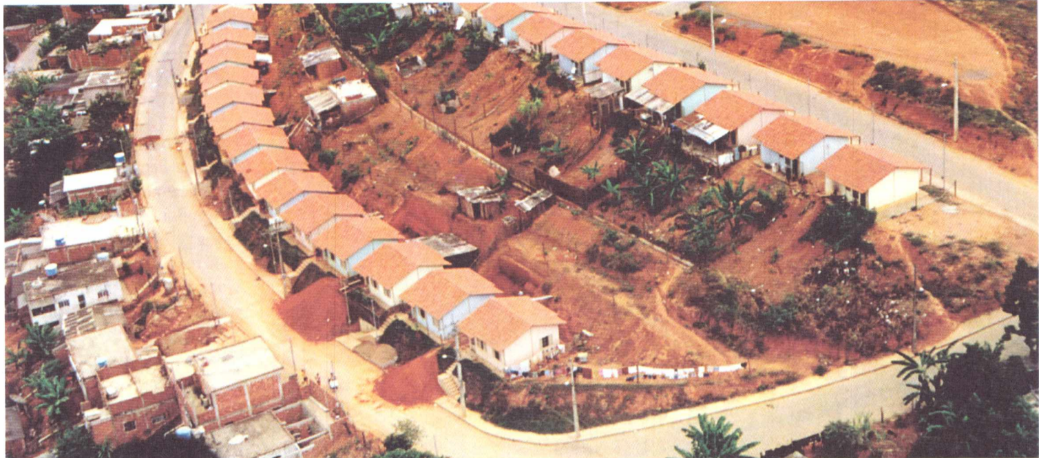
Moradias construídas no Aglomerado do Bethânia, que antes era uma favela com famílias em áreas de risco
