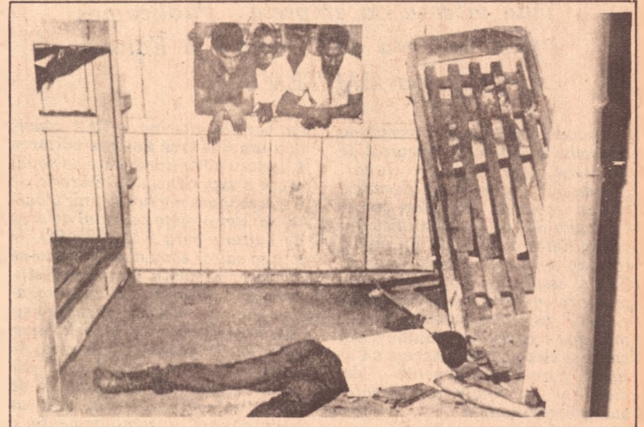
Invasão do alojamento dos operários da Usiminas.
