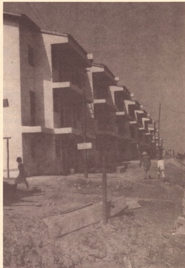
Construção de casas em mutirão, em SP
