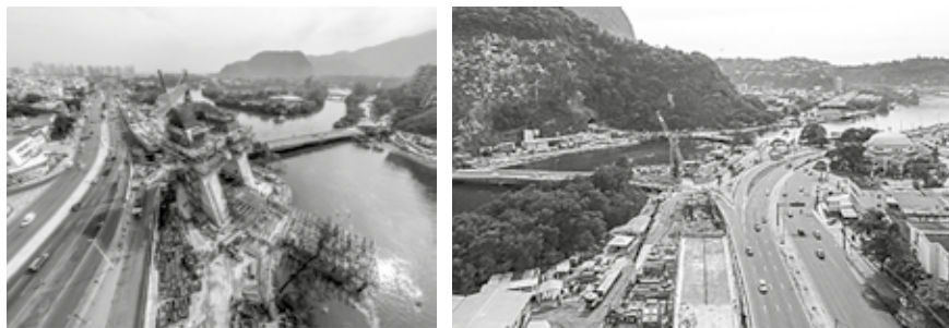
Figuras 10 e 11: Construção da Linha 4
