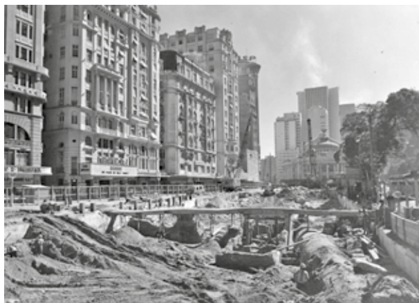
Figura 6: Construção do Metrô Rio
