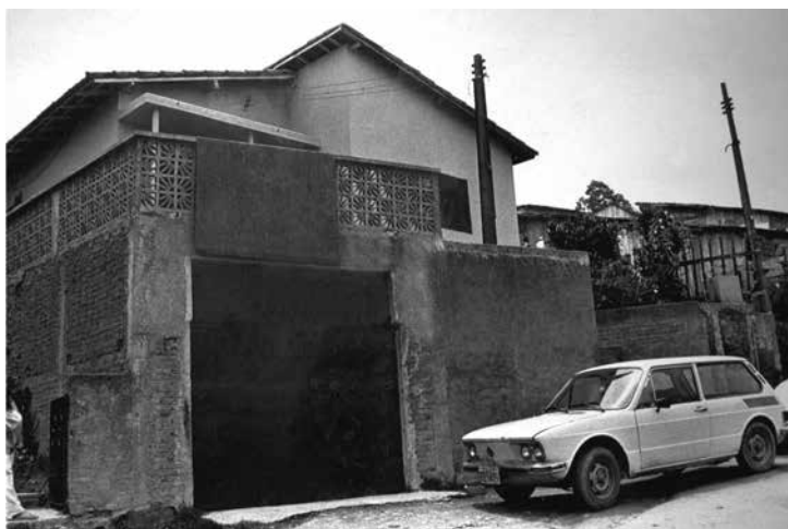
A casa no Jardim Santa Tereza já construída, em 1979; à direita, é possível ver o telhado do barraco de dona Tazinha. (álbum de família)
