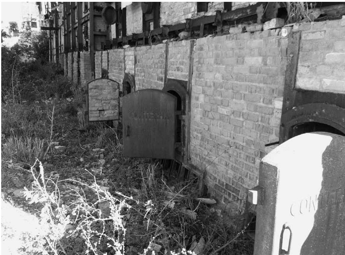
Visão geral das caldeiras da Usina Cambahyba. Fonte: Arquivo CNV
