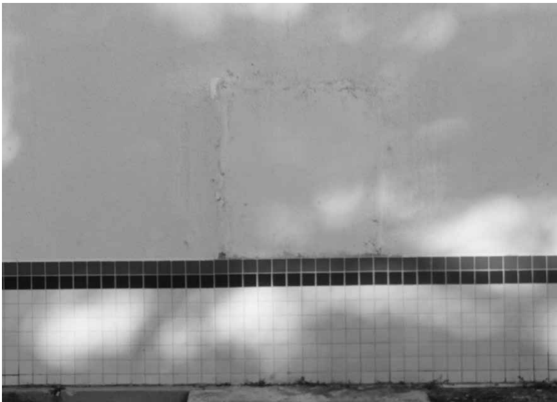
Detalhe de vão de porta fechado pela reforma, na fachada posterior da edificação. Fonte: Arquivo CNV
