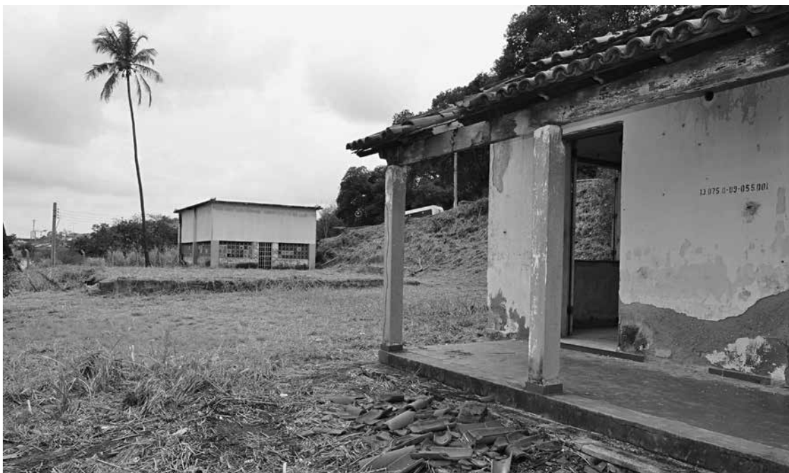
Casa de máquinas. Dos dois locais indicados pelas testemunhas, um deles foi completamente demolido. Fonte: Arquivo CNV
