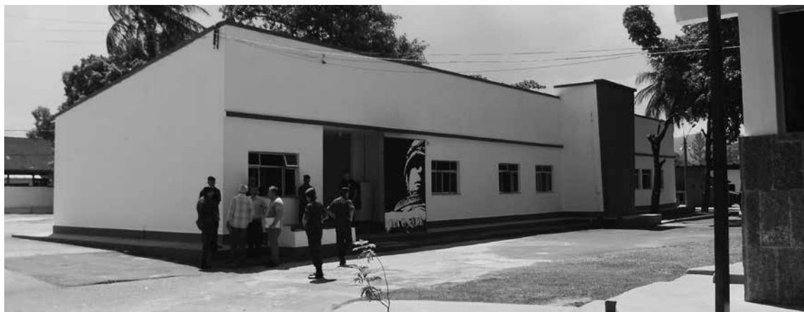
Parte anterior do prédio. Fonte: Arquivo CNV
