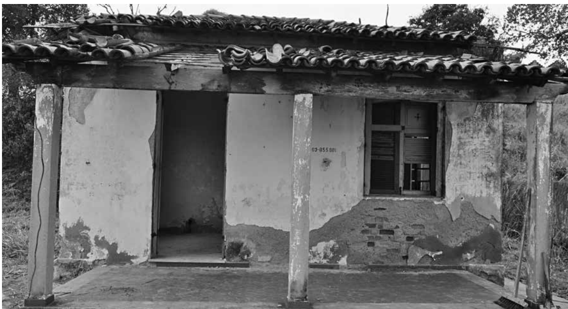
Vista frontal da edificação. Fonte: Arquivo CNV
