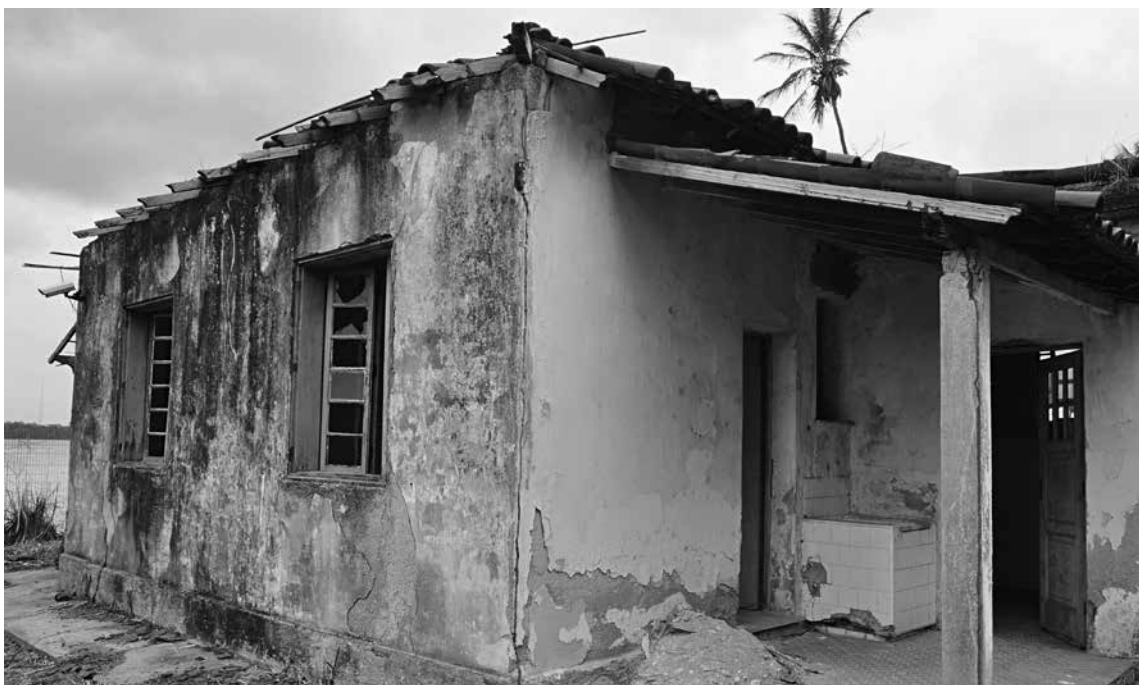
Lateral direita da edificação. Fonte: Arquivo CNV
