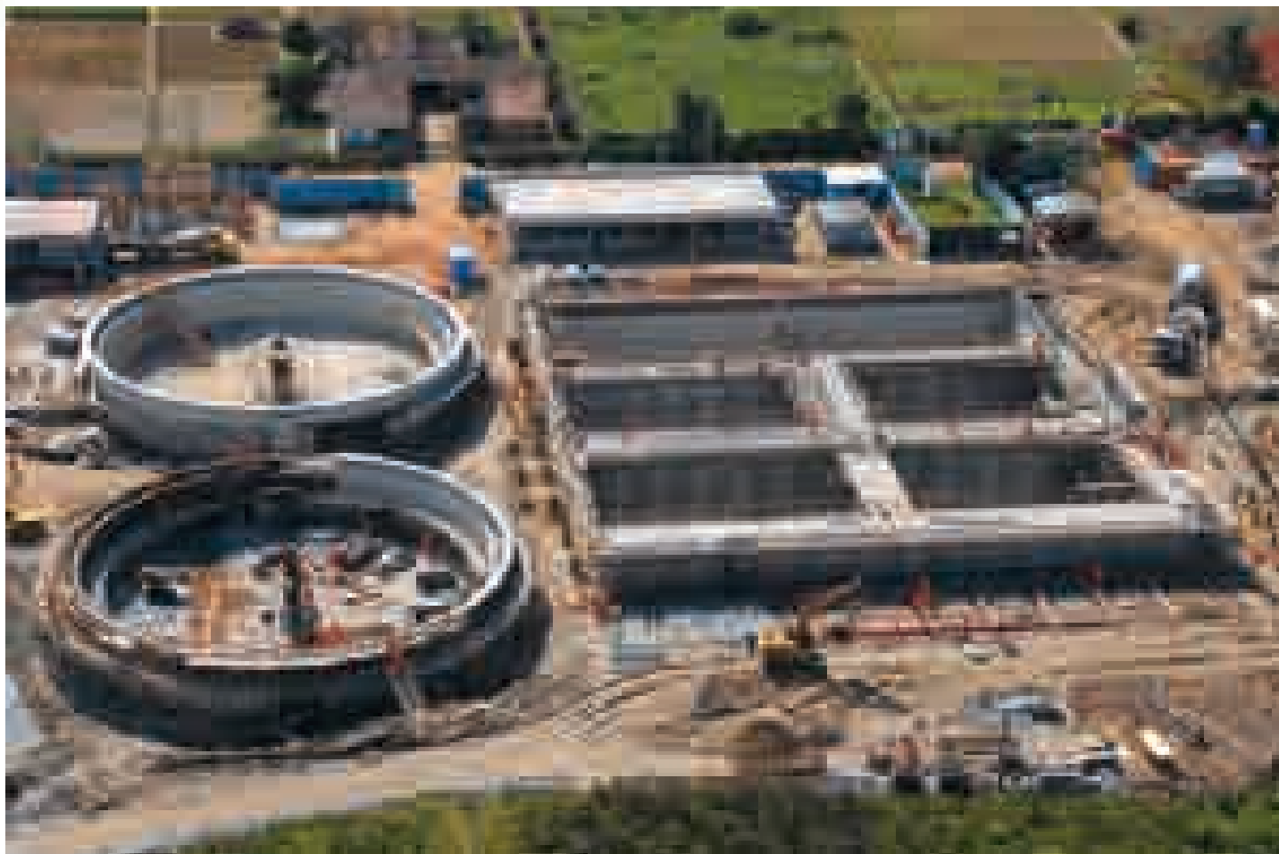
O CDES contribuiu decisivamente para a realização do PAC. Na foto, construção de estação de tratamento de esgoto em Guarulhos (SP), obra do PAC infraestrutura Urbana
