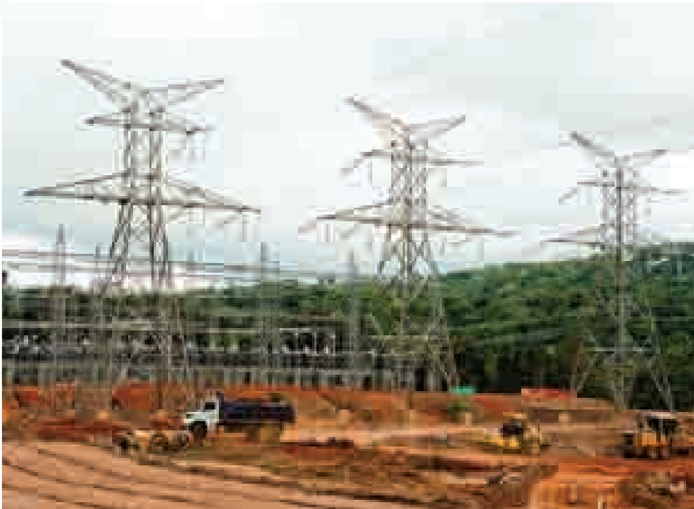
De 2003 a 2010, foram construídos 21,8 mil km de linhas de transmissão, para distribuir a energia gerada
