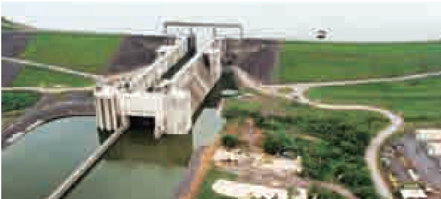
Investimentos expressivos foram destinados ao conjunto de ações de desenvolvimento. Grandes obras de infraestrutura impactaram o crescimento regional. Na foto: Eclusa de Tucuruí, no Pará
