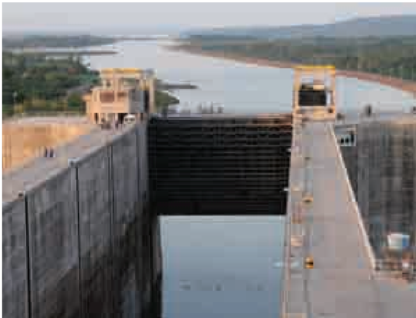
Conclusão das eclusas de Tucuruí, no Pará, restabeleceu a navegabilidade do Rio Tocantins entre Marabá e sua foz
