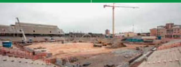
Arena da Baixada - PR 57% de execução
