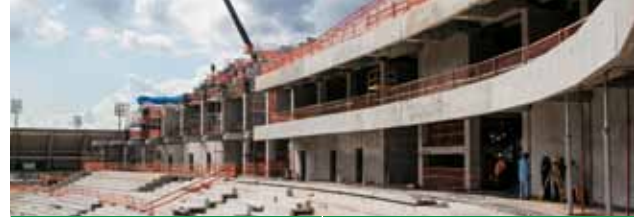
Arena da Amazônia - AM 55% de execução
