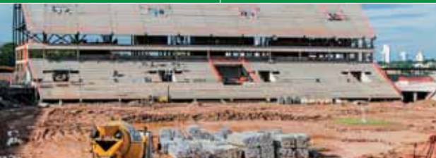
Arena Pantanal - MT 62% de execução
