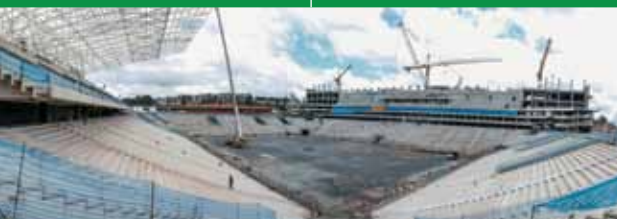
Itaqueroão - SP 66% de execução
