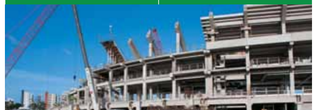
Arena das Dunas - RN 54% de execução
