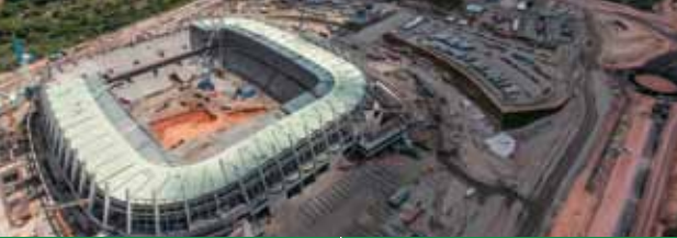
Arena Pernambuco - PE 90% de execução
