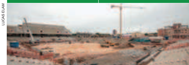
Arena da Baixada - PR 57% de ejecución
