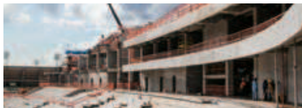
Arena da Amazônia - AM 55% de ejecución
