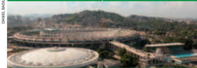
Maracanã - RJ 87% de ejecución
