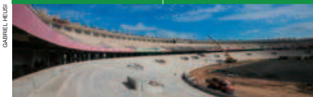
Beira Rio - RS 58% de ejecución
