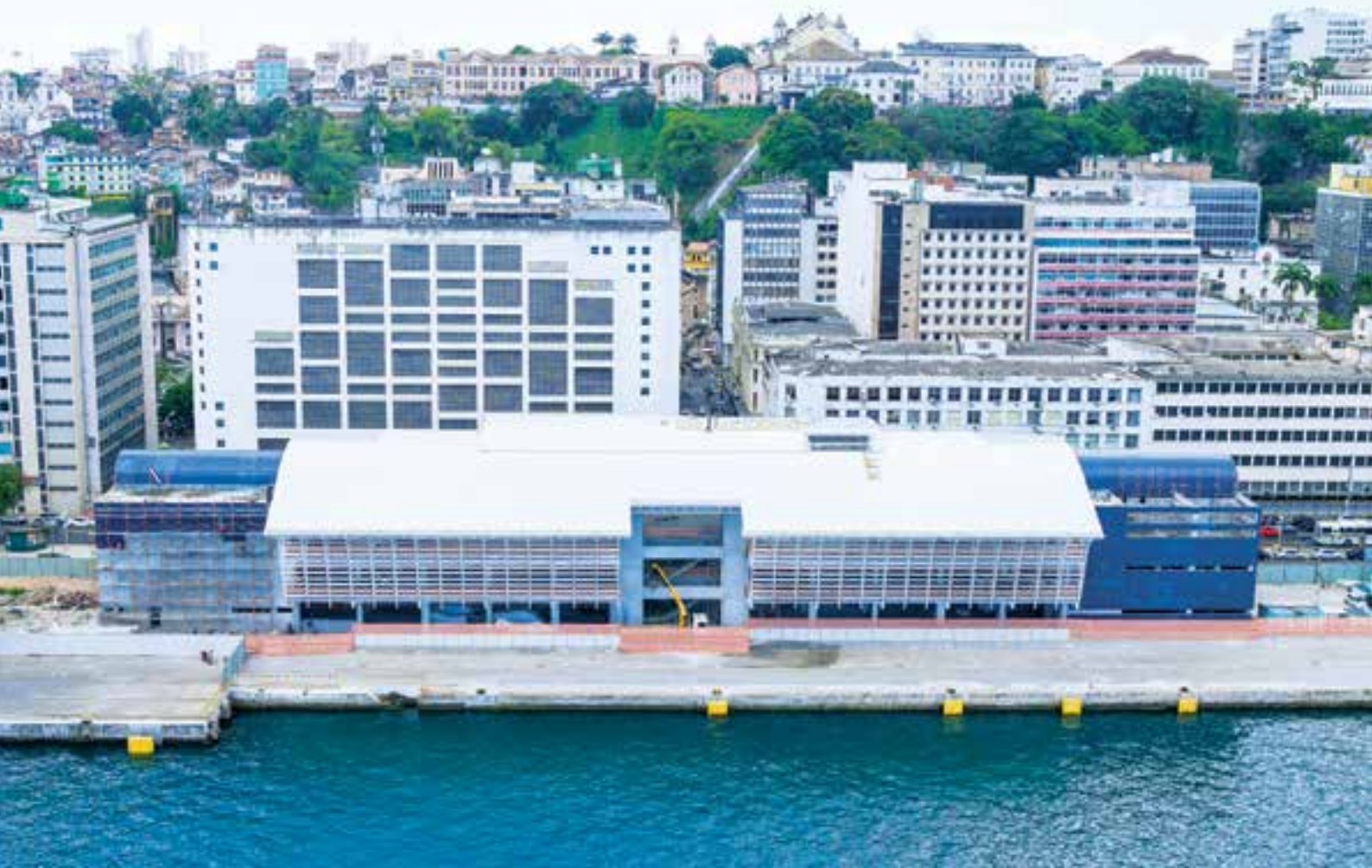
Terminal de passageiros do Porto de Salvador (BA)
