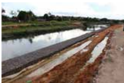
Obras de macrodrenagem no Parque Linear II
