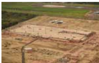
Construção do novo Terminal de Cargas
