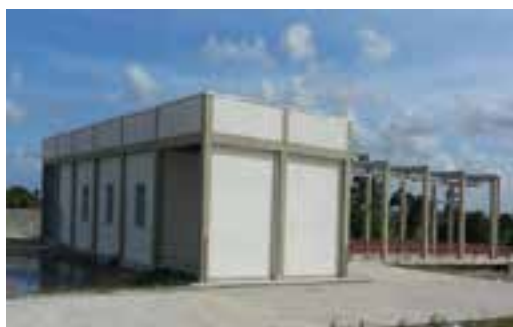
Estação Elevatória de Água Bruta 02
