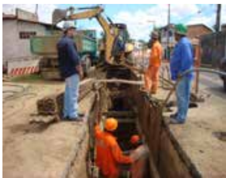
Bacia SD-06 - Implantação de coletor tronco na Av. Perimetral
