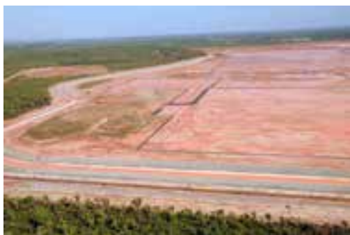
Terraplenagem da Refinaria Premium I
