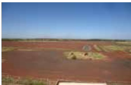
UFN V – Terraplenagem
