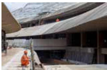
Reforma e modernização do TPS
