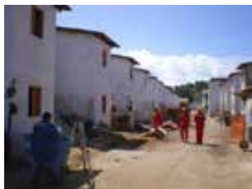
Habitacional na Comunidade Pipoqueira – Olinda/PE
