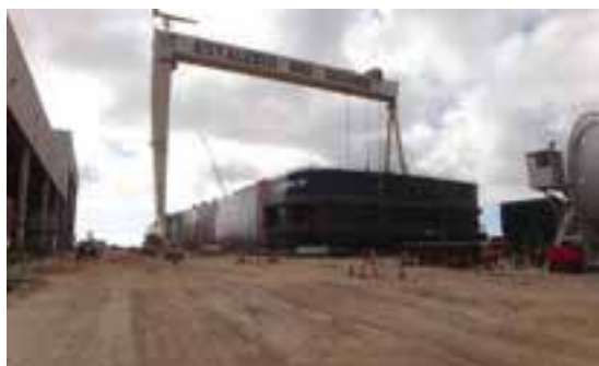
Edificação dos blocos da P-66 dentro do dique seco
