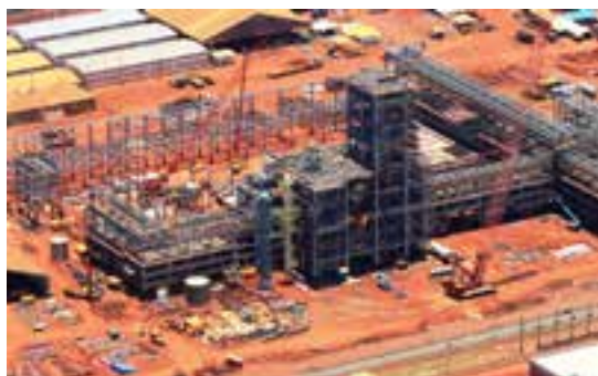
Montagem da Unidade de Ureia
