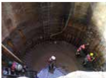
Vertente 2 da ETE São Miguel Poço de Visita (PV3T) - Travessia
