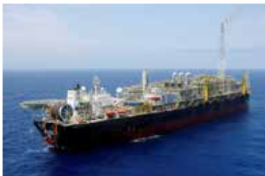
FPSO Cidade de São Paulo em operação
