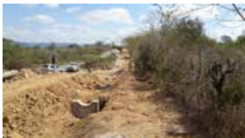
Instalação dos Pipe Rack – Trecho Pesqueira - Alagoinha
