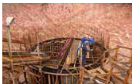
EEE - Armação de Ferragens – Trobogy - Salvador
