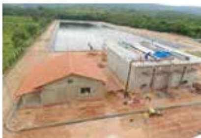
Estação de Tratamento de Esgoto de Buenópolis/MG
