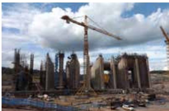
Casa de Força – Vista geral
