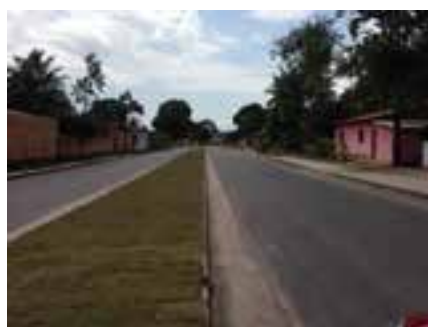
Pavimentação Avenida Três Corações
