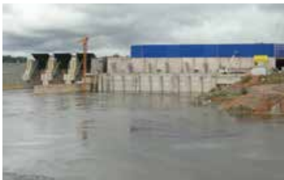
Casa de Força e vertedouro – Vista de jusante
