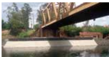
Canal de Igaráçu – Reforço da proteção de pilares da margem direita concluído
