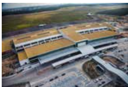
Reforma e ampliação do TPS
