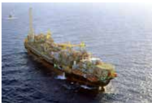
Plataforma P-58 na locação
