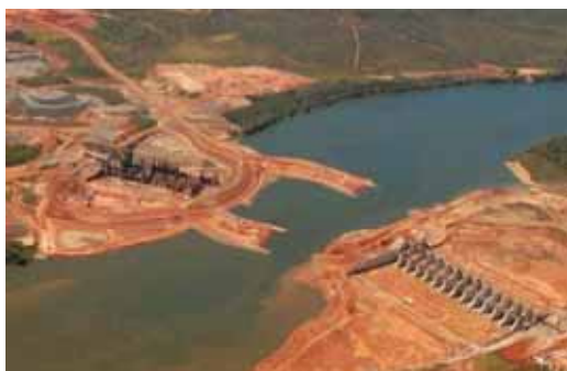
Vertedouro - vista de jusante
