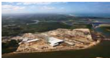
Construção do Estaleiro Atlântico Sul
