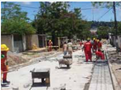
Pavimentação e drenagem na UE 13 – Olinda
