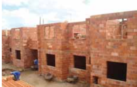
Alvenaria de elevação do Residencial Patativa do Assaré
