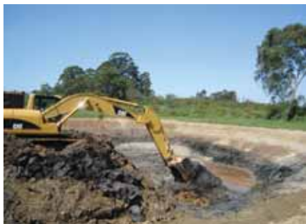
Escavação para construção da ETE São João
