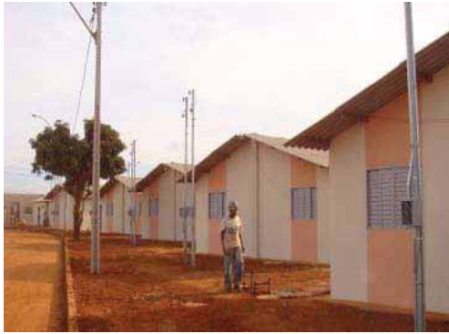
Unidades habitacionais concluídas
