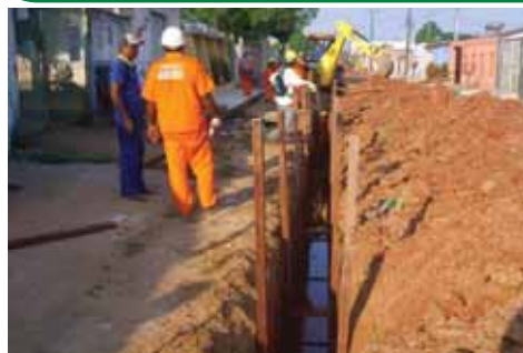
Assentamento de rede coletora
