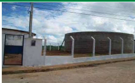
Reservatório de sistema de abastecimento
