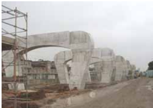
Elevação da Linha Férrea – Avenida Leopoldo Bulhões
