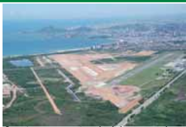
Construção novo terminal de passageiros
