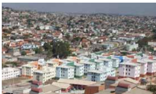
Vista geral das obras na Vila São José
