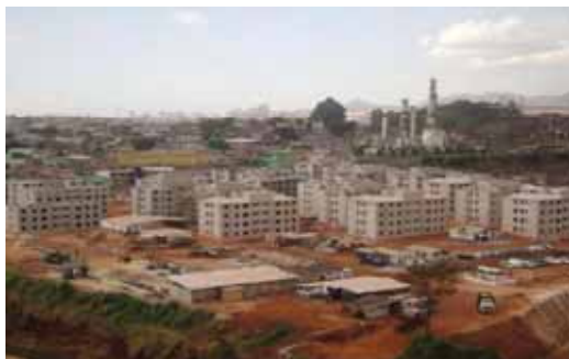
Construção de unidades habitacionais em Contagem
