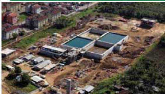
Estação de Tratamento de Esgoto Sudoeste – Itanhaém
