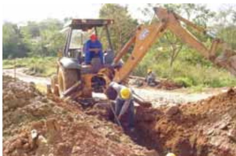
Execução de rede coletora de esgoto sanitário
