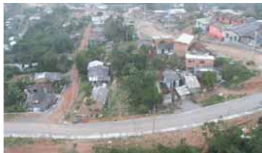
Pavimentação e abertura de novas ruas
