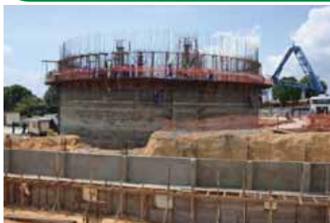
Concretagem do reservatório Núcleo 23
