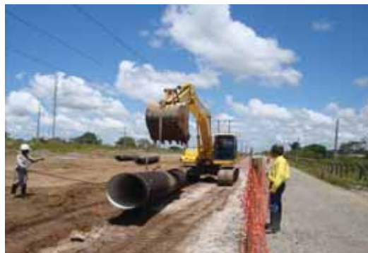
Assentamento de adutora de água bruta
