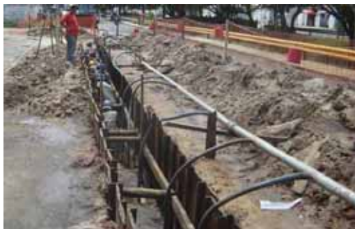
Instalação de redes coletoras em Aracaju
