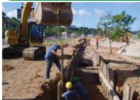
Assentamento de interceptor em Salvador
