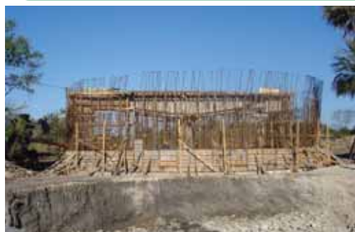
Execução do reator da ETE Maria Leite
