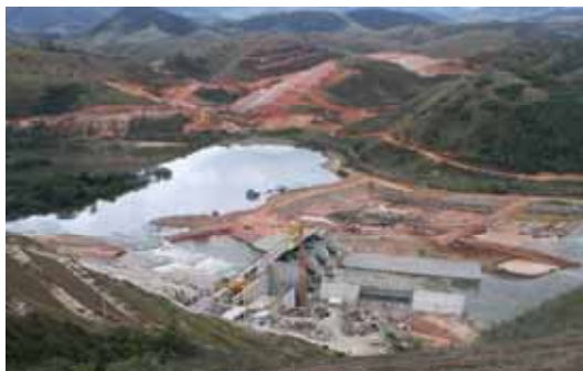
Casa de Força – vista geral
