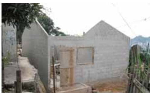
Construção de unidades habitacionais no Forte São João
