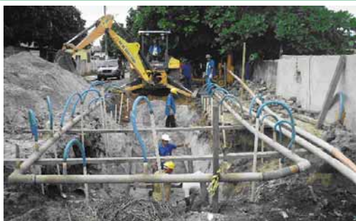
Escavação de galerias com rebaixamento de lençol freático
