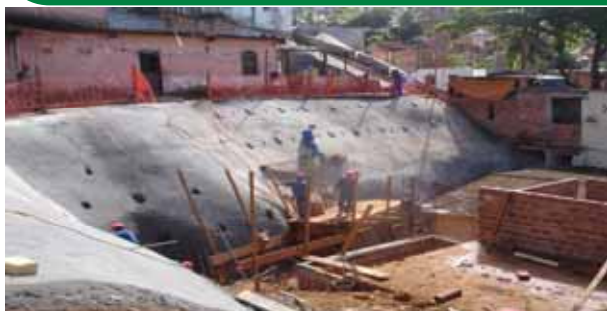
Obras de contenção em Alto de Ondina
