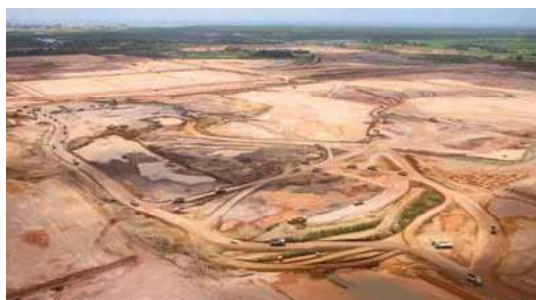
Refinaria Abreu e Lima – terraplanagem
