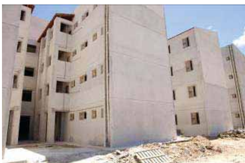
Construção de 352 unidades habitacionais no bairro da Imbiribeira
