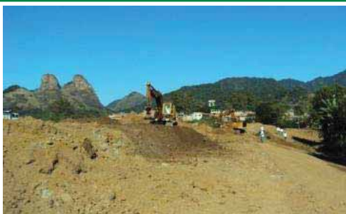
Obras de urbanização da comunidade Entre Rios
