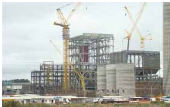
Obras – vista aérea
