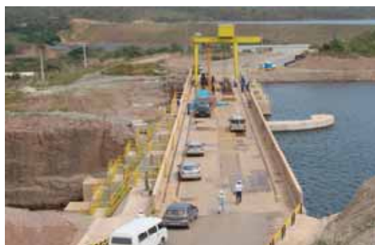
Montante – vista geral
