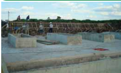
Ampliação da ETE São Francisco
