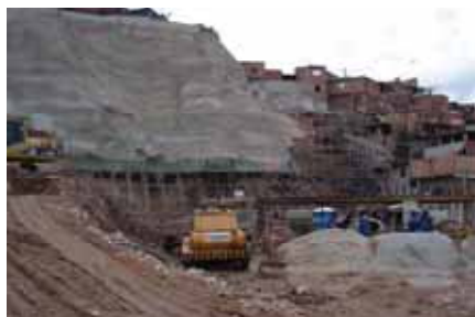
Obras de contenção no bairro Cidade Júlia
