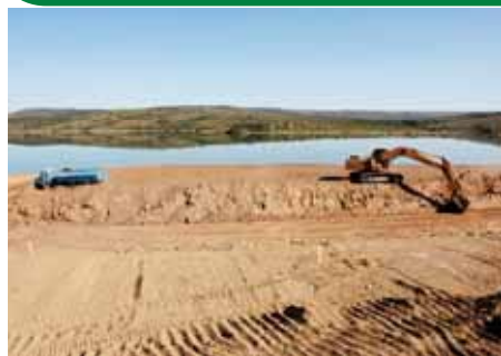
Terraplanagem na área da captação – GO
