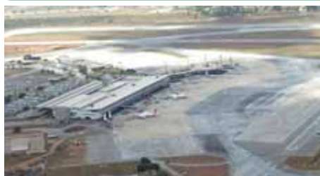
Reforma e Ampliação Sul do TPS
