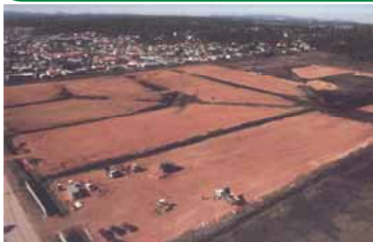
Serviços preliminares em execução no loteamento
