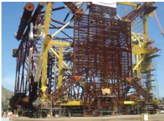
Estrutura da Plataforma no Estaleiro Mauá
