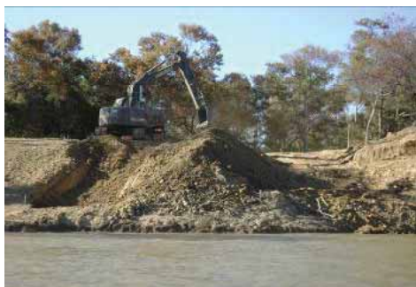
Obras na margem direita
