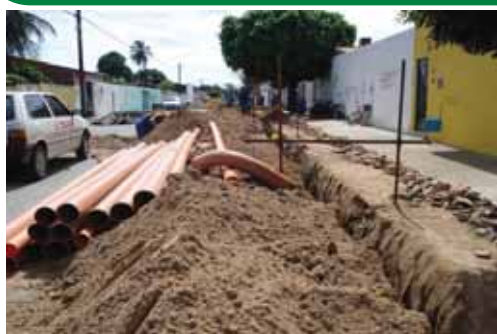
Assentamento de rede coletora
