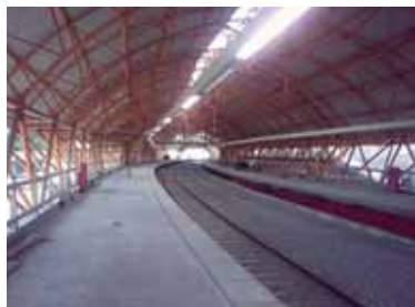
Implantação da via permanente na estação Brotas
