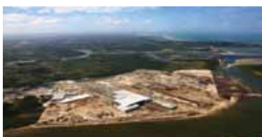
Construção do Estaleiro Atlântico Sul
