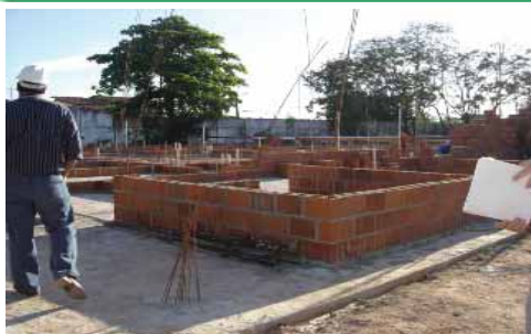
Execução de alvenaria de 264 unidades habitacionais verticais - Terreno 1
