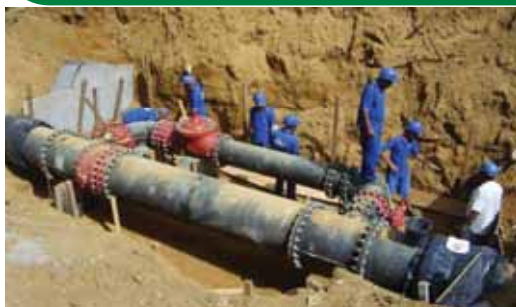
Montagem das estruturas de controle do sistema de água
