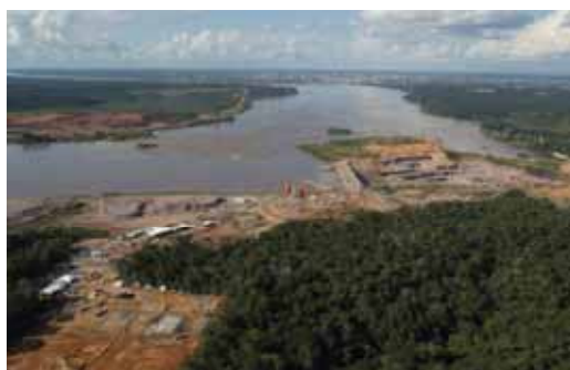
Escavações em Rocha
