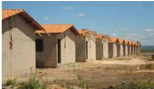
Construção de unidades habitacionais
