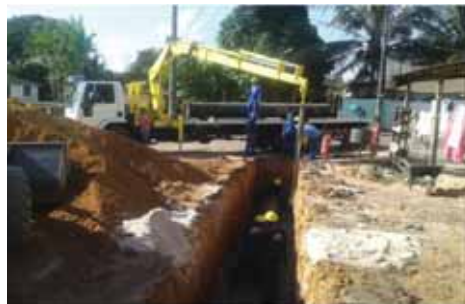
Adução em execução
