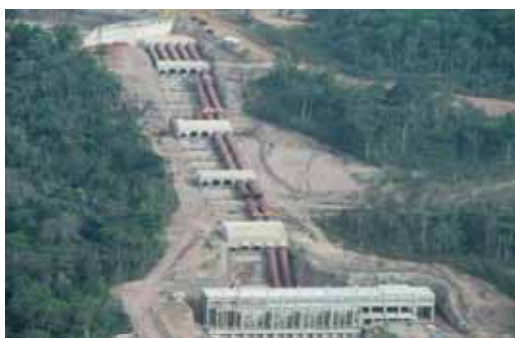
Conduto Forçado – vista geral
