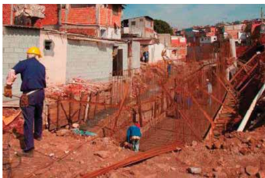
Obras de infraestrutura na Gleba K
