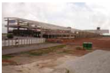
Construção novo terminal de passageiros
