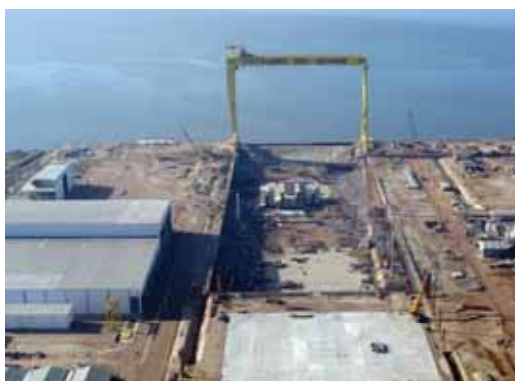
Obras do Estaleiro Rio Grande
