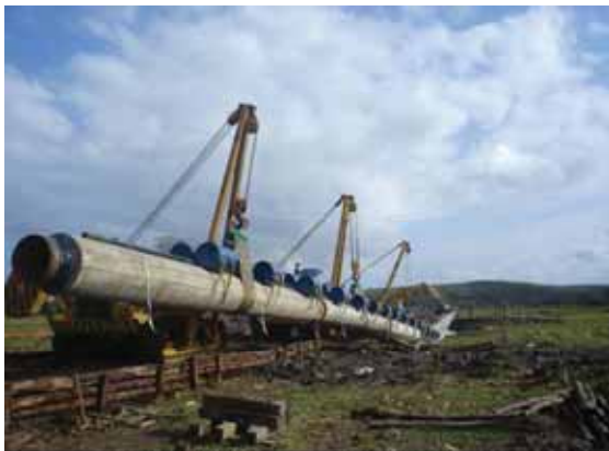
Obras no Gasoduto
