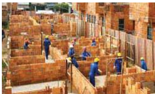
Construção das unidades habitacionais
