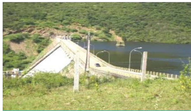
Recuperação da Barragem Jucazinho (PE)
