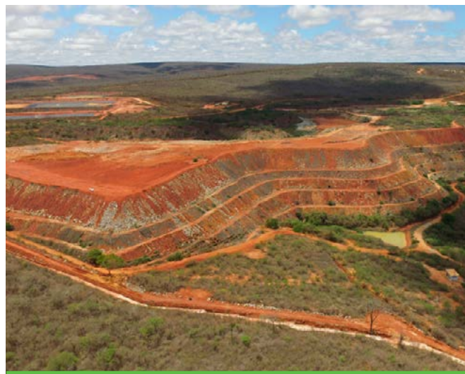
Depósito de Estéril e de Minério Lixiviado, Caetité (BA)
