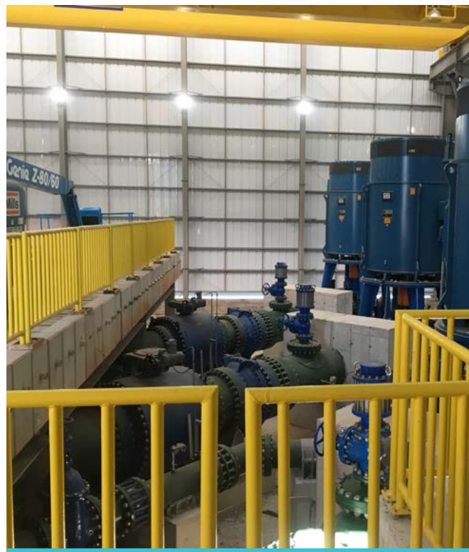
Vista para interior da EEAB Jaguari - grupos motobomba (G4, G5 e G6) (SP)
