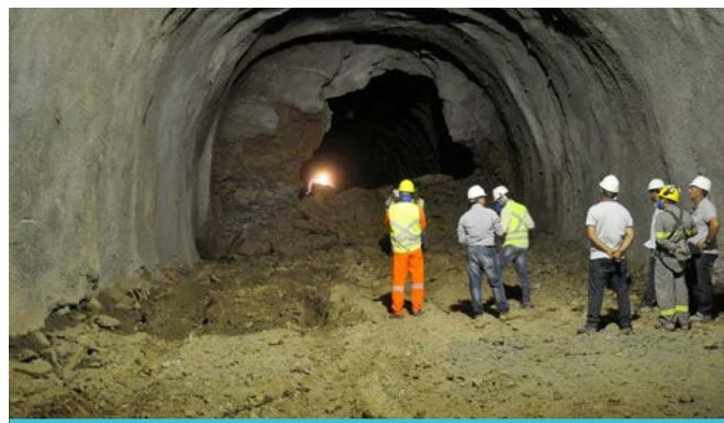
Eixo Norte do PISF - Túnel Milagres (PE)
