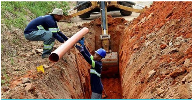
Assentamento da tubulação em Araguaína (TO)
