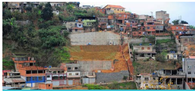
Obras de contenção de encostas em Juiz de Fora/MG
