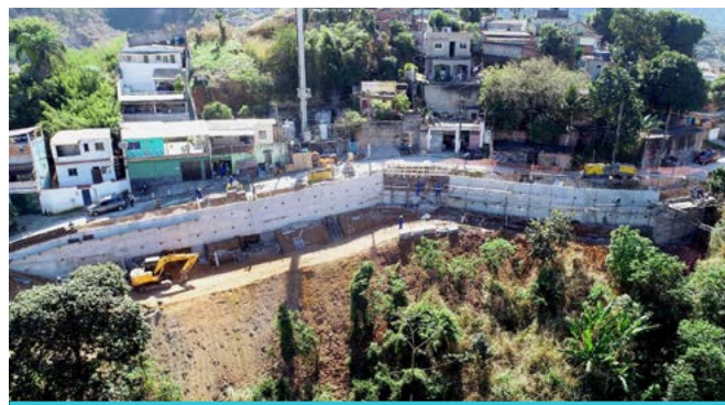
Obras de contenção de encostas no Bairro Caramujo em Niterói/RJ
