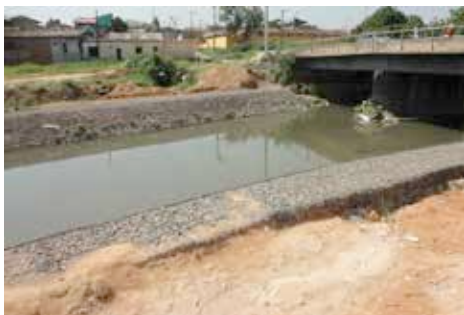
Obras de macrodrenagem no segundo trecho do parque linear
