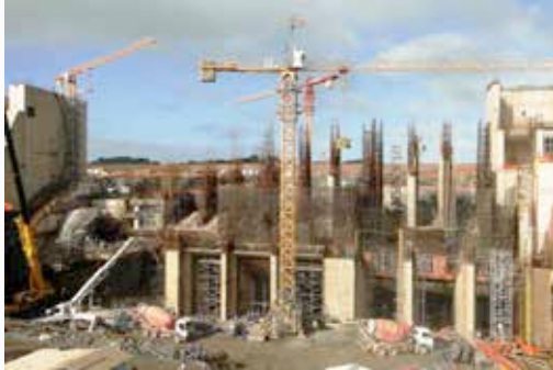
Casa de força – vista de jusante
