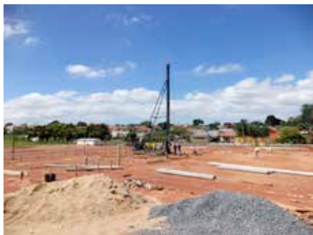
Início das obras do Centro Comunitário São Domingos
