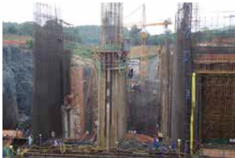
Tomada d'água – vista de montante
