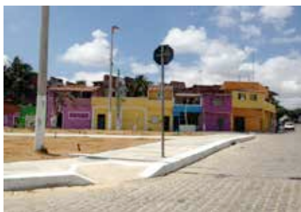
Melhorias habitacionais na Orla
