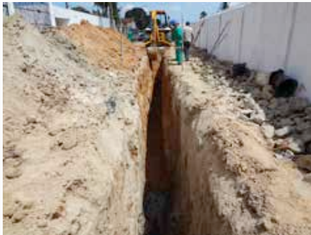
Implantação de redes coletoras no bairro Manuel Sátiro
