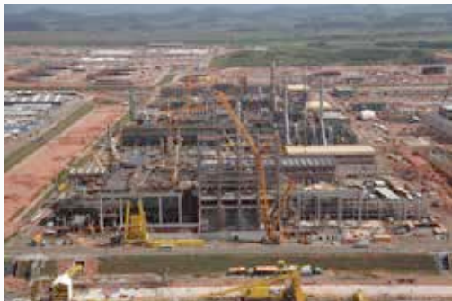
Montagem da planta industrial – COMPERJ
