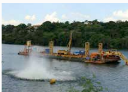
Canal de Igaráçu – Detonação para remoção de pontos altos no canal
