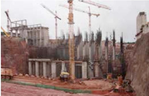
Casa de força – vista jusante
