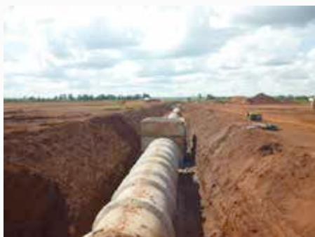
UFN V – Obras de drenagem
