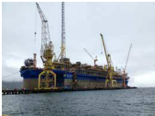
FPSO Paraty em obras no estaleiro Brasfels
