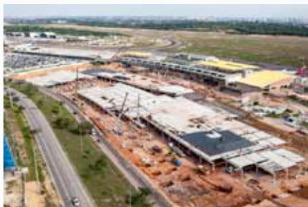
Reforma e ampliação do TPS
