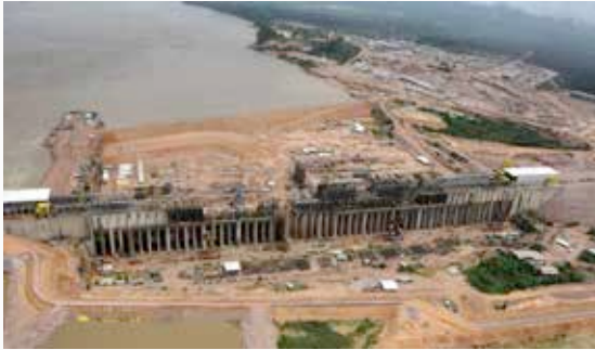
Casa de força – margem direita
