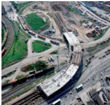
Vista da obra
