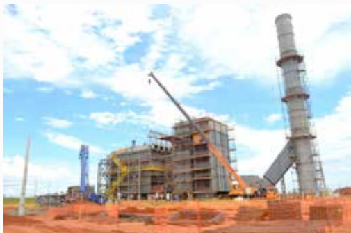
Construção e montagem do forno
