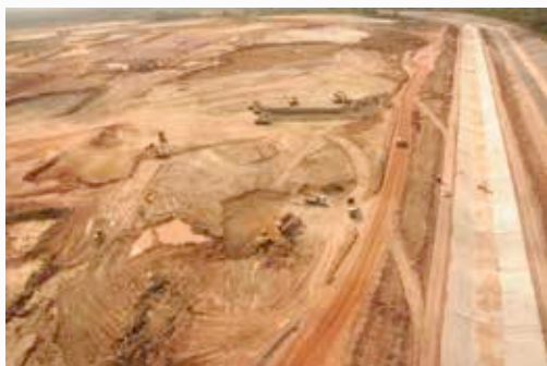
Terraplenagem da Refinaria Premium I
