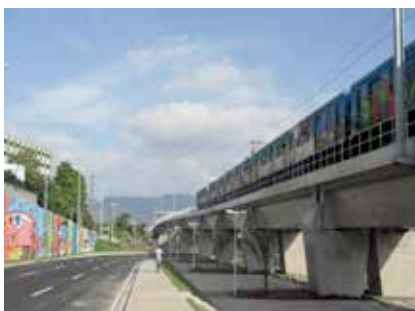
Via férrea elevada
