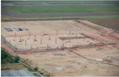
Construção do novo Terminal de Cargas
