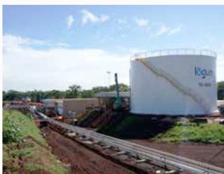
Terminal de Ribeirão Preto
