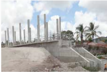
Canal de aproximação da captação
