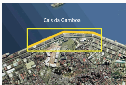
Vista aérea Porto do Rio
