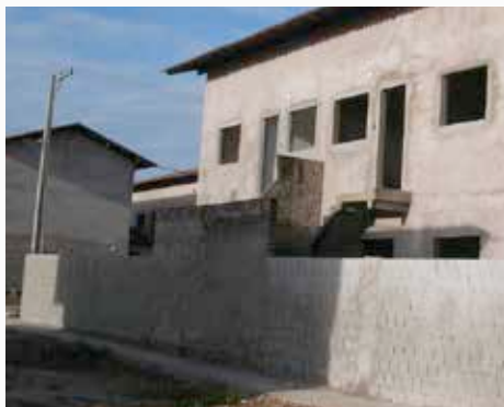
Unidades habitacionais em Jaderlândia
