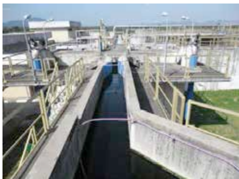
ETE Cubatão – Unidade de tratamento preliminar
