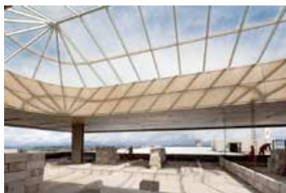
Reforma e modernização do TPS
