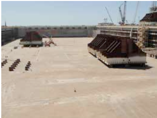
Montagem dos blocos da P-66 dentro do dique seco
