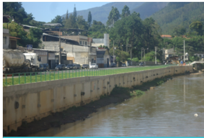
Ampliação da calha do Rio Betim – Betim (MG)
