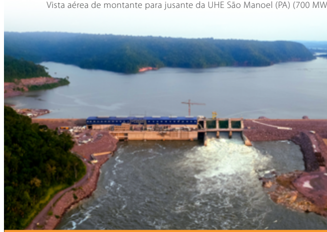
Vista aérea de montante para jusante da UHE São Manoel (PA) (700 MW)
