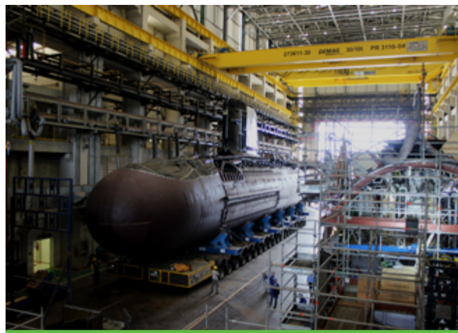
Construção do Submarino Riachuelo, UFEM - Unidade de Fabricação de Estruturas Metálicas, Itaguaí-RJ.
