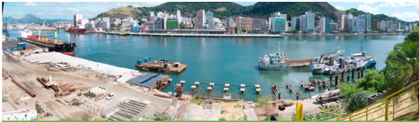
Construção de berços nos dolphins do Atalaia com retroárea (ES)
