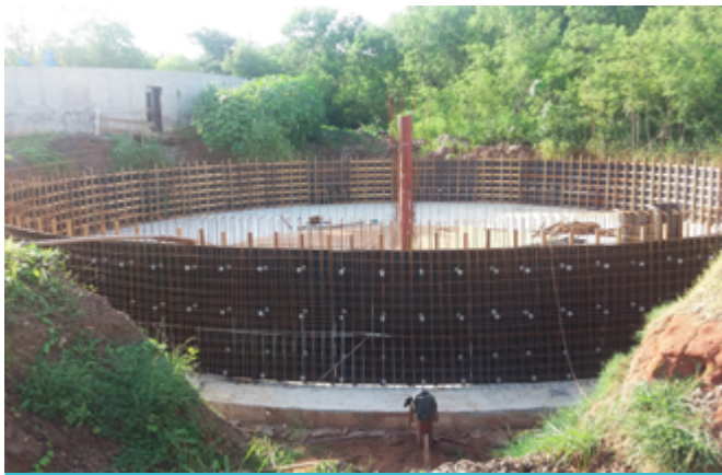
Ampliação do Sistema de Esgotamento Sanitário - Três Lagoas (MS)
