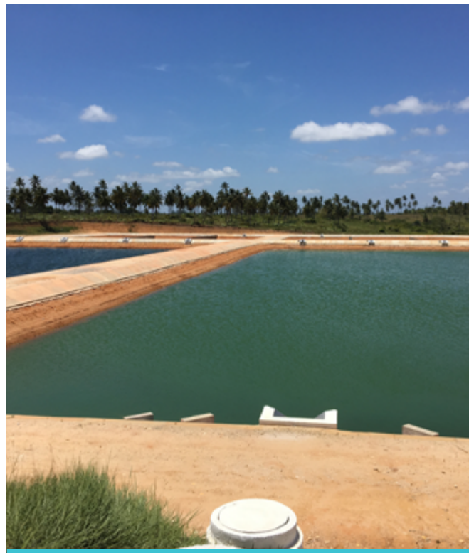
Implantação do Sistema de Esgotamento Sanitário – ETE – Conde (BA)
