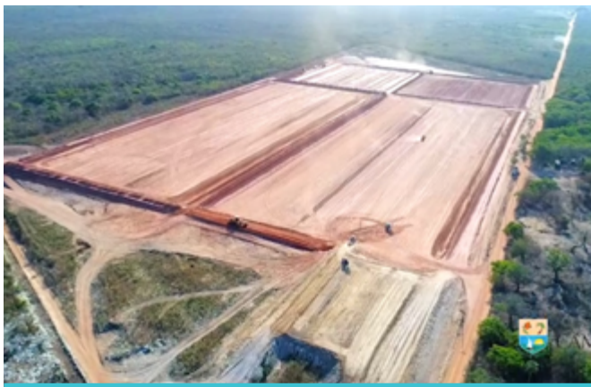
Ampliação do Sistema de esgotamento sanitário – Camocim (CE)
