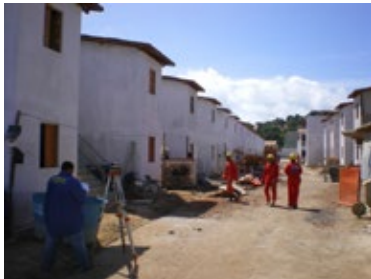
Habitacional na Comunidade Pipoqueira – Olinda/PE
