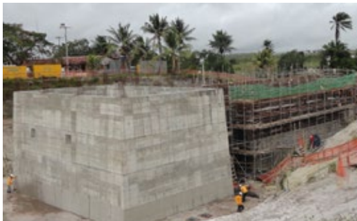
Concretagem de estação elevatória de água bruta
