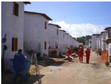
Habitacional na Comunidade Pipoqueira – Olinda/PE
