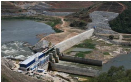
Casa de força – visão geral
