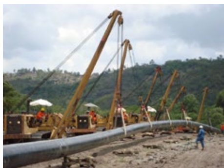
Trecho Ribeirão Preto – REPLAN em obra
