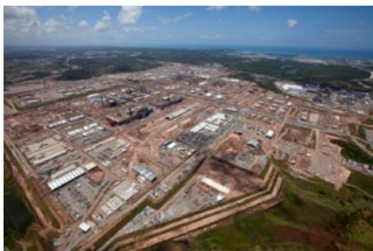
Instalações da Refinaria Abreu e Lima
