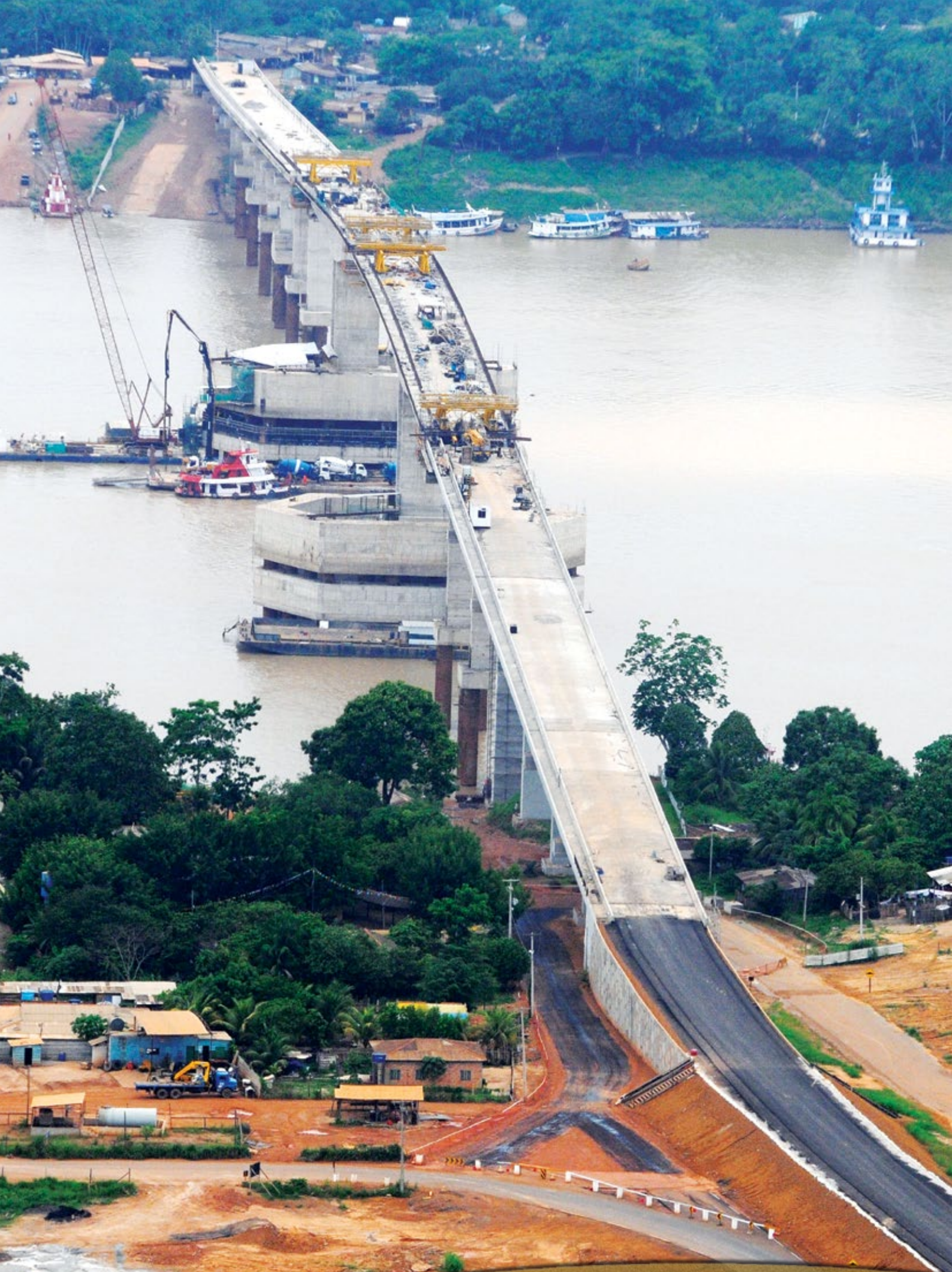
BR 319/RO - PONTE SOBRE O RIO MADEIRA | RO
