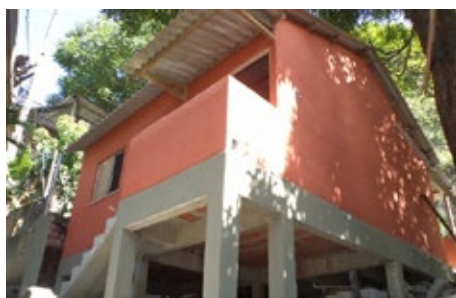
Reconstrução de unidade habitacional
