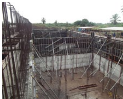
Filtro da ETE ERQ Oeste
