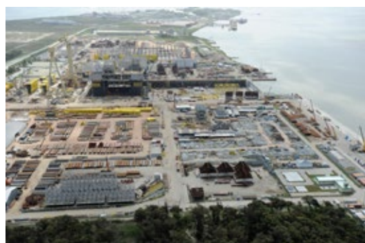
Vista aérea do estaleiro Rio Grande com blocos da P-66
