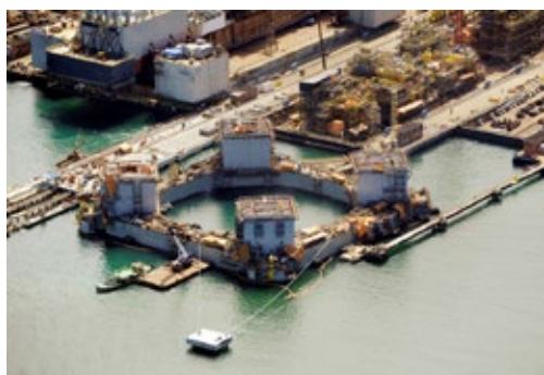
Casco da plataforma P-61 no estaleiro Brasfels
