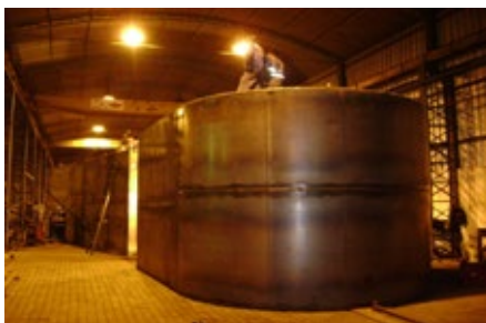
SP-425 – Vista da proa da proteção flutuante
