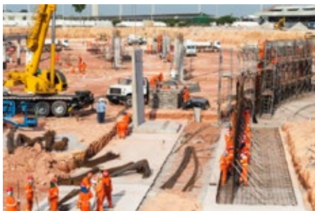
Reforma e ampliação do TPS
