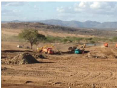
Mobilização de canteiro de obras
