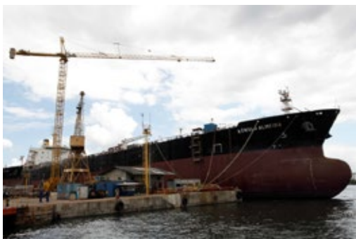
Obras do Navio Rômulo Almeida
