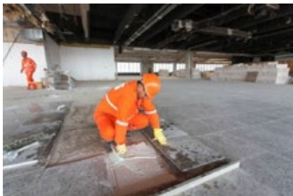
Reforma e modernização do TPS
