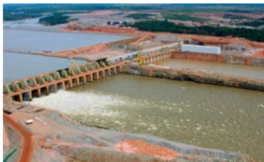
Casa de força e vertedouro
