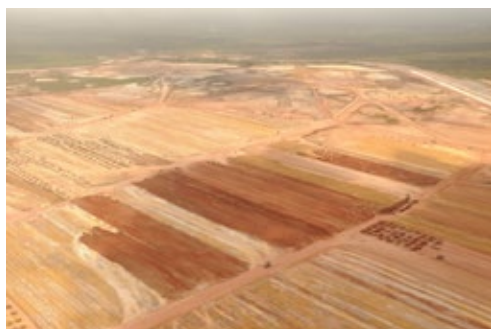
Terraplenagem da Refinaria Premium I
