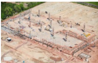
Construção do novo Terminal de Cargas
