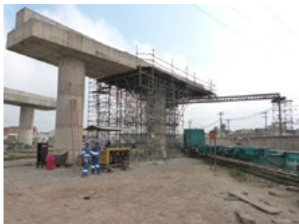
Vista da obra
