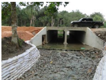
Obras do sistema viário do corredor ecológico
