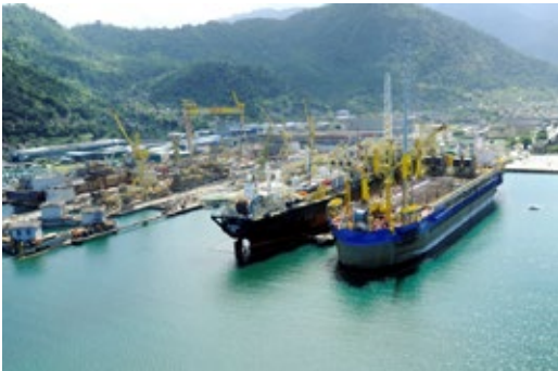
FPSO Paraty em obras no estaleiro Brasfels
