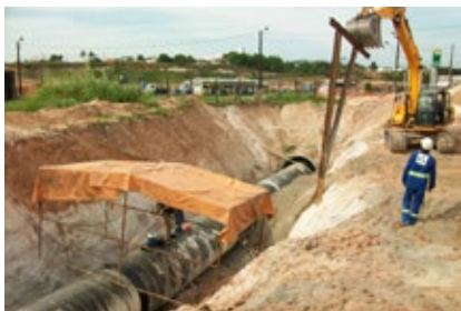
Travessia da adutora de água tratada
