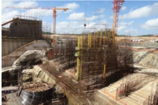
Tomada d'água – vista geral
