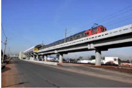
Estação Rio dos Sinos – em operação comercial
