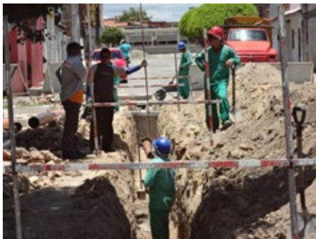
Implantação de redes coletoras no bairro Parangaba
