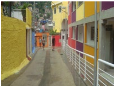
Melhorias de acesso concluídas na Rocinha
