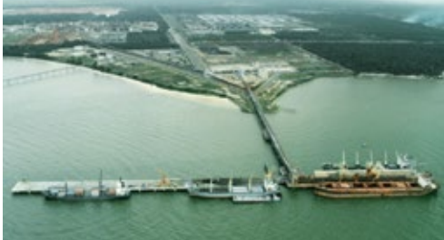
Alargamento do Berço 302 – Construção Píer 400
