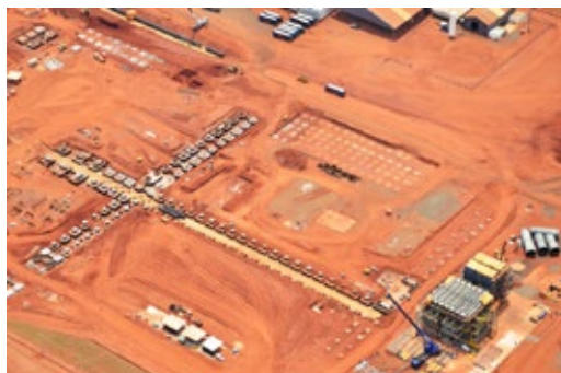
Vista aérea – montagem dos dutos e forno
