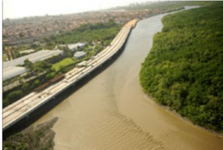
Sistema viário nas margem do rio Anil
