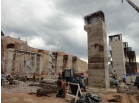
Circuito de geração – montagem da estrutura
