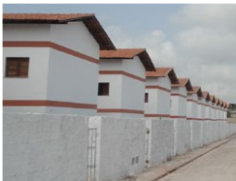
Unidades habitacionais em Jaderlândia
