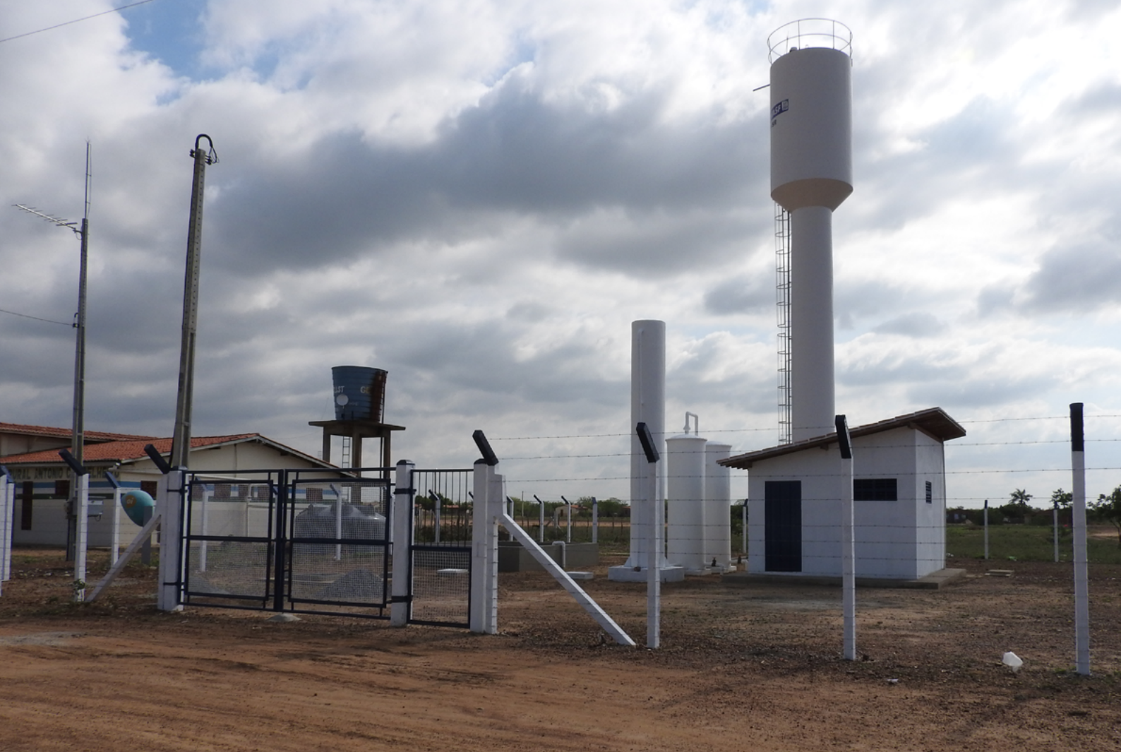
Implantação do Sistema de Abastecimento de Água em localidades rurais difusas, em Casa Nova (BA)
