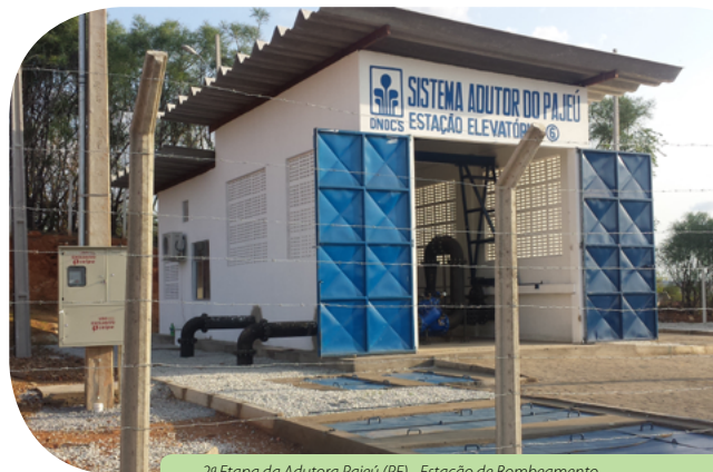
2ª Etapa da Adutora Pajeú (PE) - Estação de Bombeamento
