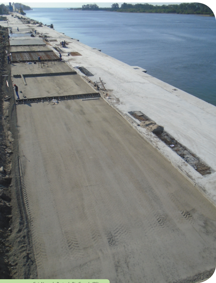
Cais Novo do Porto de Rio Grande (RS)
