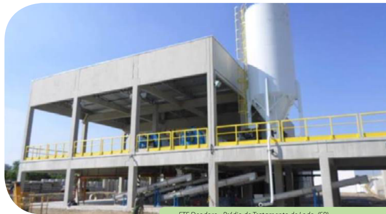
ETE Deodoro - Prédio de Tratamento de Lodo (SP)
