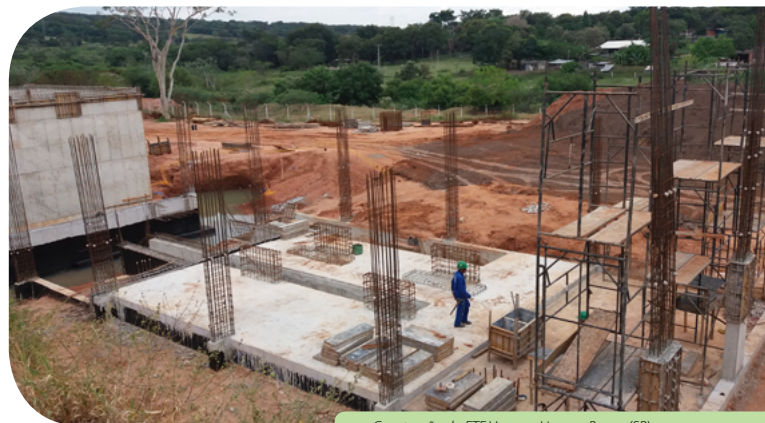
Construção da ETE Vargem Limpa - Bauru (SP)
