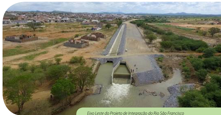
Eixo Leste do Projeto de Integração do Rio São Francisco Chegada da água ao leito do rio Paraíba, em Monteiro (PB)
