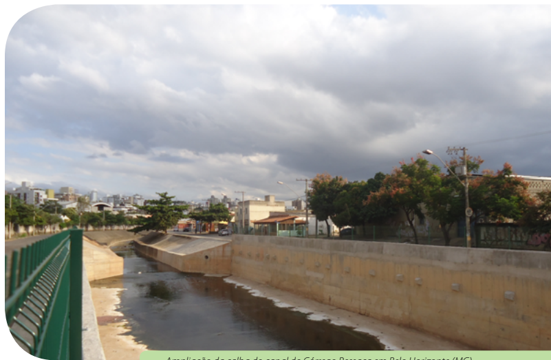
Ampliação da calha do canal do Córrego Ressaca em Belo Horizonte (MG)
