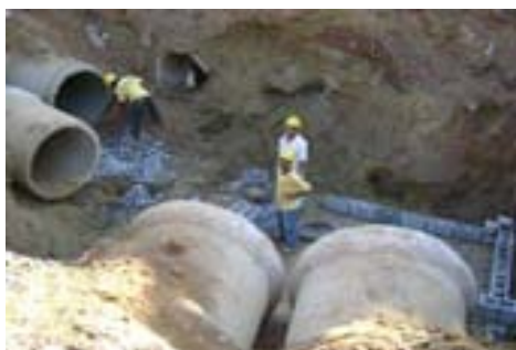
Obra de esgotamento sanitário no entorno de Viracopos
