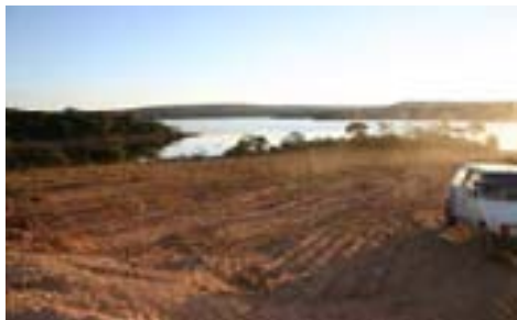
Execução do reator ETE
