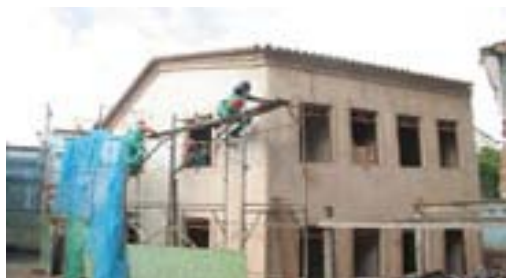
Restauração de casarão no centro histórico de Salvador
