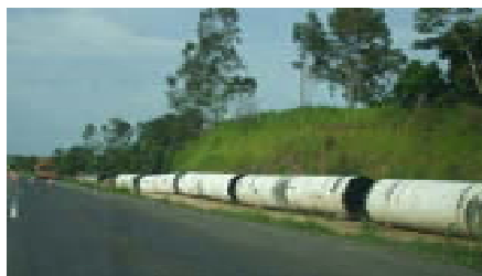
Distribuição de tubos para instalação da adutora
