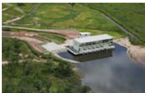
Canal de aproximação
