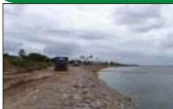
Contenção de erosão na margem do São Francisco
