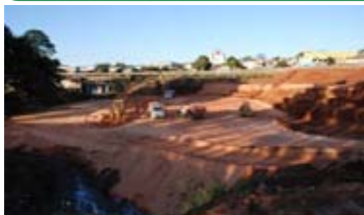
Obras no ribeirão Arrudas
