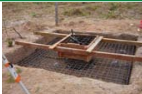
Concretagem base da torre
