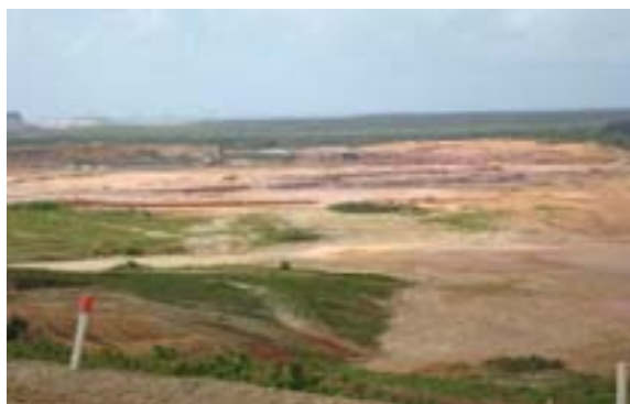
Refinaria Abreu e Lima – terraplanagem
