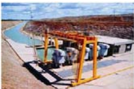
Estação de bombeamento 2
