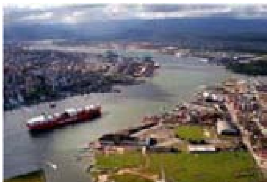
Dragagem de aprofundamento no canal de acesso
