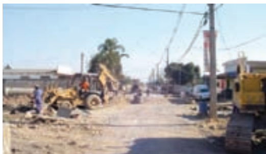
Obras em Guarituba
