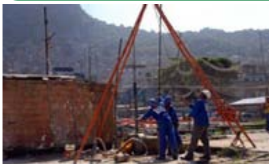
Obras na Rocinha
