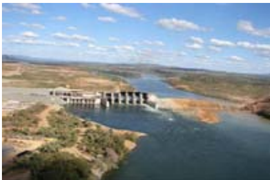
Vista da casa de força
