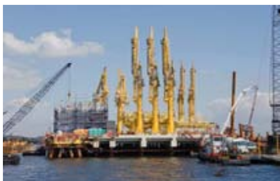
Vista geral do pier
