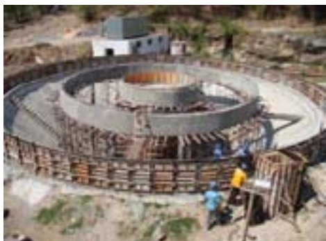
Execução do reator da ETE
