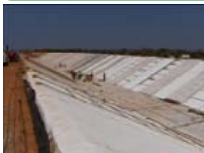
Geomembrana – revestimento do canal
