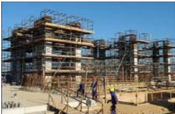
Vista das obras
