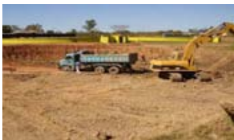
Execução do novo reator da ETE
