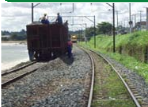
Substituição de lastro na via
