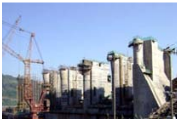
Vista do vertedouro
