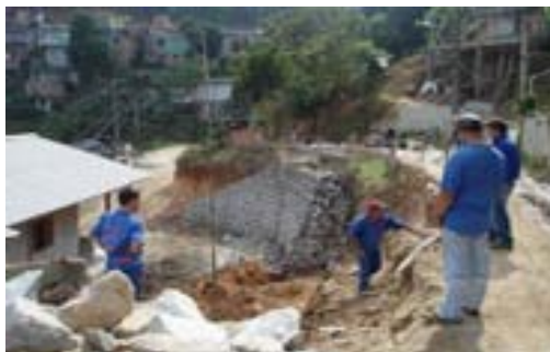
Obras de contenção no Morro da Cruz
