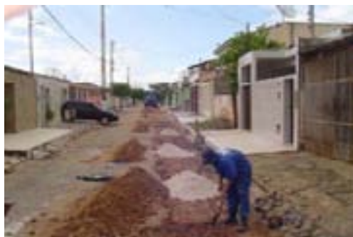
Instalação de redes coletoras em Aracaju
