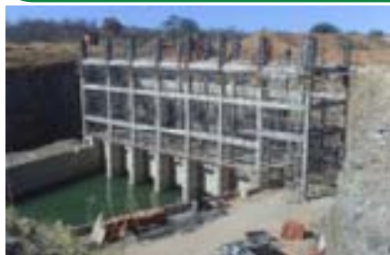
Estação de bombeamento
