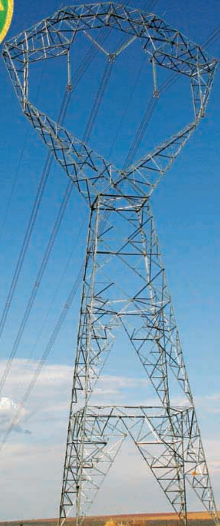
Linha de Transmissão Serra da Mesa 2, trecho da GO-118 Setembro/2008
