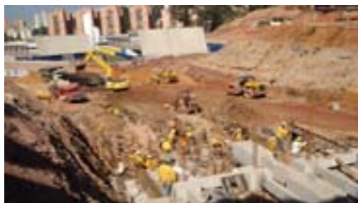
Obras condomínio F
