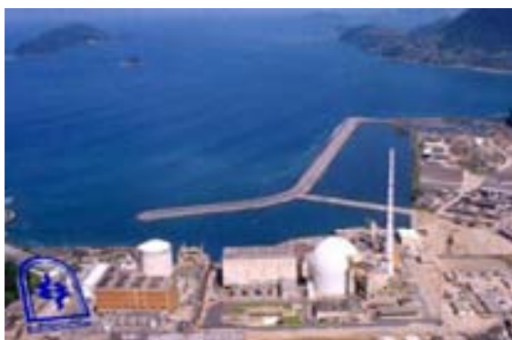
Vista geral das usinas
