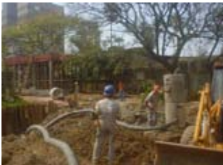
Montagem do sistema de drenagem, rebaixamento de lençol freático e subestação de energia do Sistema Sarandi
