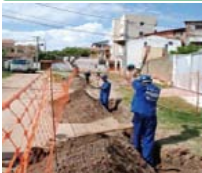
Obras no bairro Jardim Piatã em Salvador
