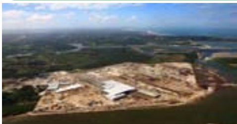
Construção do Estaleiro Atlântico Sul
