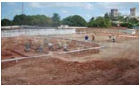
Construção das unidades habitacionais
