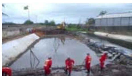
Obras no Canal da Malária
