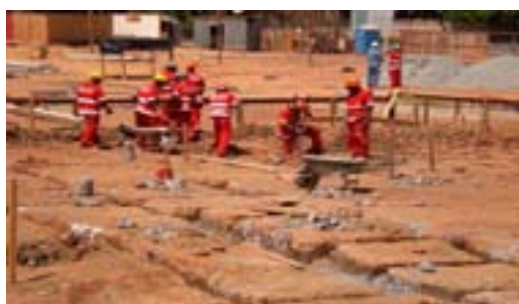
Vista geral das obras na vila São José
