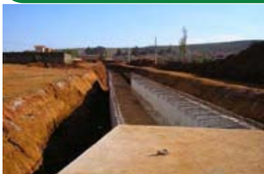
Obras em Nova Lima
