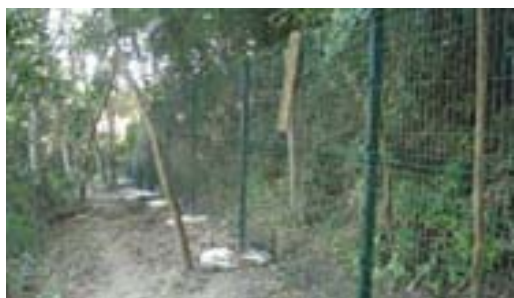
Cerca de proteção à área de preservação permanente
