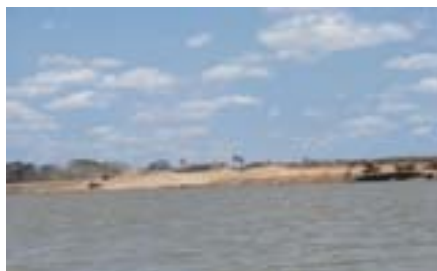
Serviço de retaludamento de margens em Barra/BA
