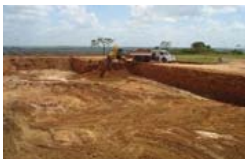
Ampliação da ETA Gramame
