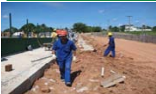
Execução da calçada de contorno
