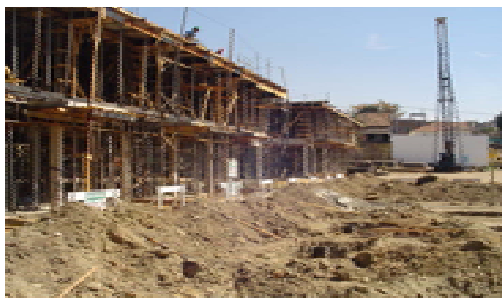
Obras no Complexo do Alemão
