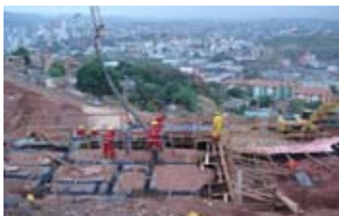
Obras Pedreira Prado Lopes
