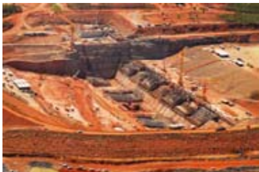
Vista geral das obras
