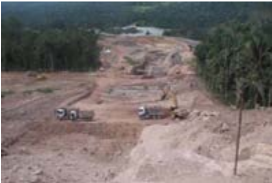
Vista do conduto forçado
