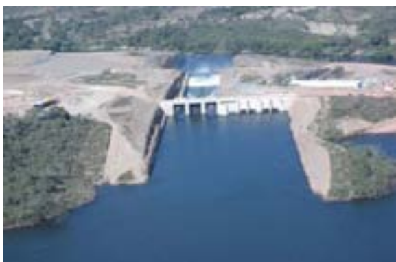
Vista geral de montante
