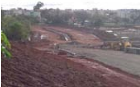
Obras de infra-estrutura em Vila Dique
