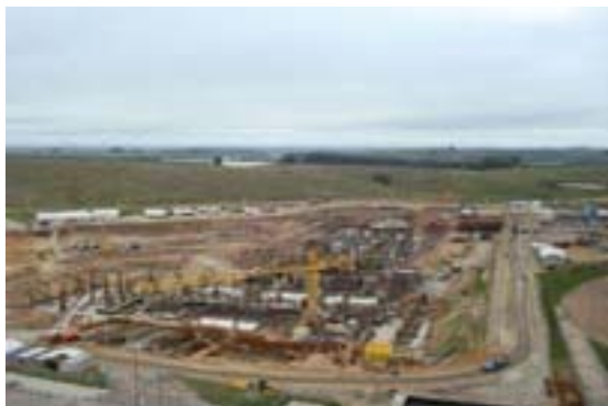
Vista aérea das obras
