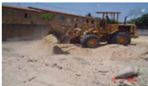
Obras na área de reassentamento
