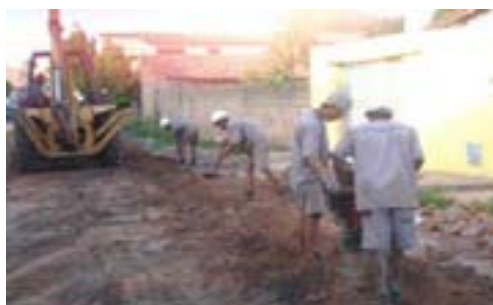
Obra da bacia do rio Siqueira Direito – 6
