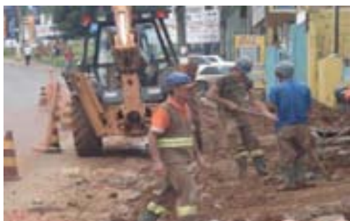
Obra de esgotamento sanitário em Guarulhos
