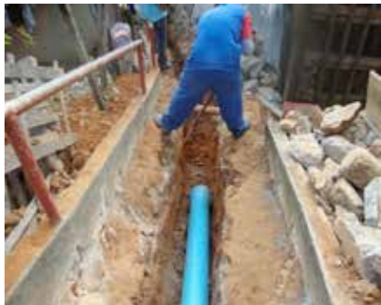
Implantação de rede de esgoto no bairro Cruzamento
