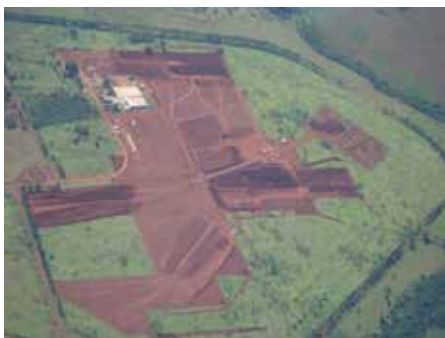
UFN V Vista aérea da terraplanagem
