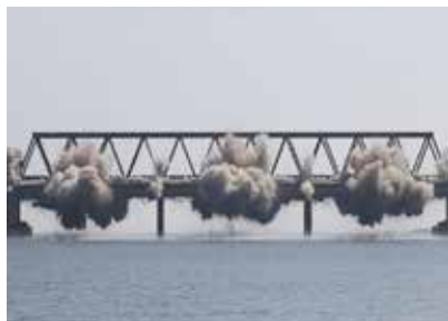
Demolição do vão da ponte SP-333
