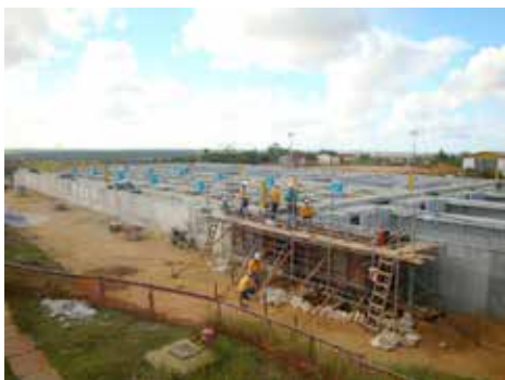
Ampliação da ETA - GRAMAME
