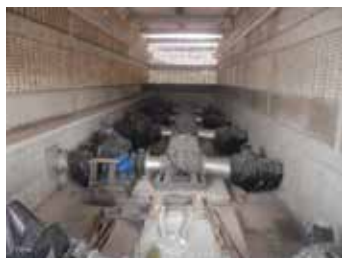
Estação elevatória EE 1
