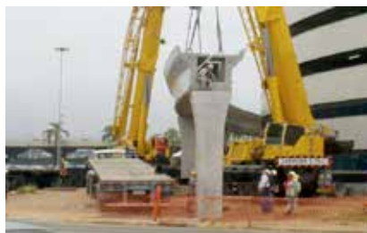
Montagem do elevador
