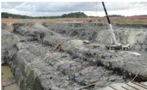
Tomada d'água, casa de força e vertedouro
