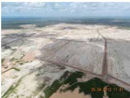
Terraplenagem da Refinaria Premium I
