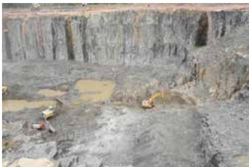
Vista geral – escavações
