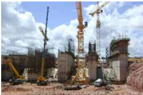
Vertedouro – vista jusante
