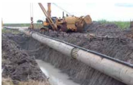
Sistema Logístico de Etanol – Instalação de Duto
