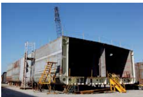
Estaleiro Superpesa - montagem dos blocos
