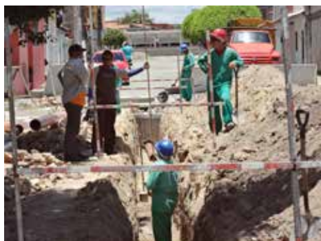
Implantação de redes coletoras no bairro Parangaba
