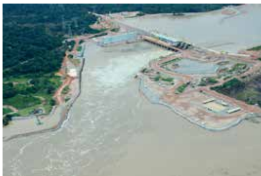
Casa de força e vertedouro
