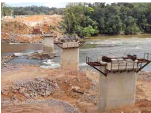
Ponte rodoviária – calha do rio
