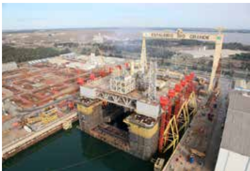
Deck Mating da plataforma P-55
