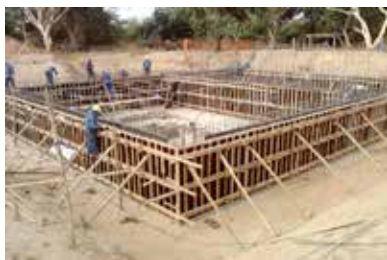
Captação - Montagem de formas da casa de bombas e sucção
