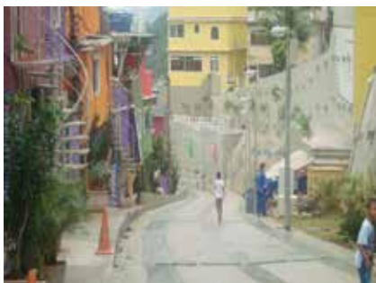
Obras de contenção concluídas na Rocinha
