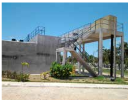
ETE ERQ Sul
