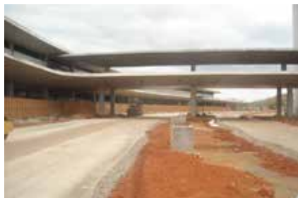
Reforma e modernização do TPS
