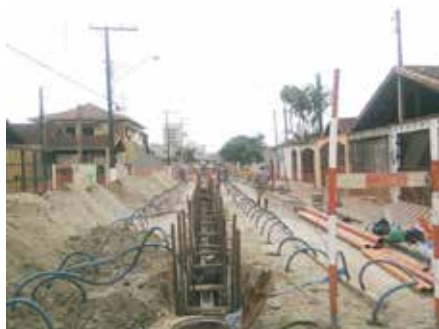
Implantação de rede coletora de esgoto em Mongaguá
