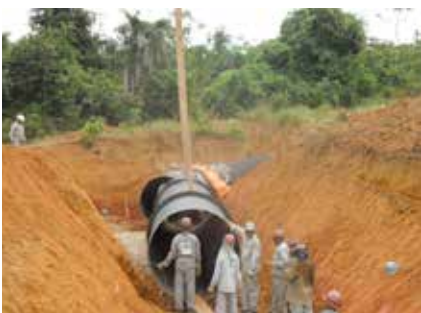
Assentamento da adutora de água bruta – Travessia Braskem
