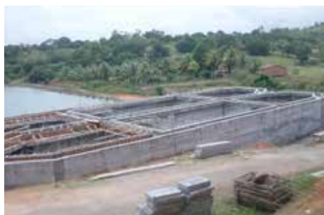
Aerador da ETE São Francisco do Conde
