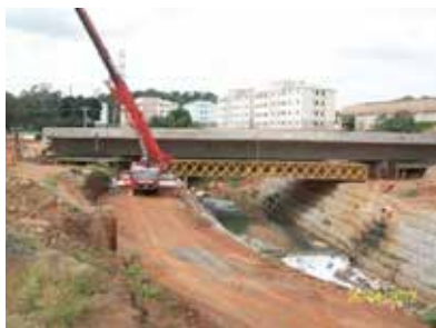
Produção de UH e construção de ponte
