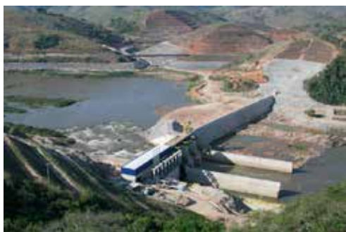
Visão geral – barragem e vertedouro
