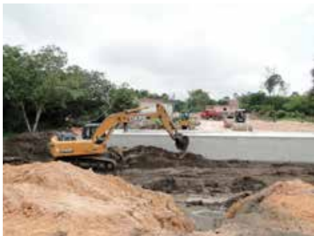
Obras do sistema viário do corredor ecológico
