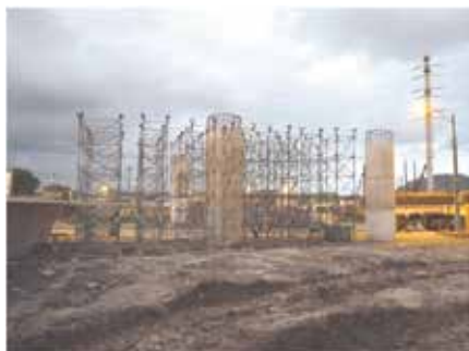
Vista da obra
