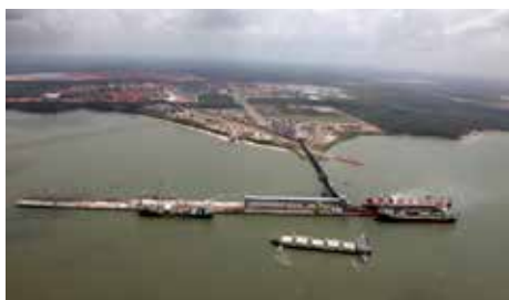
Alargamento do Berço 302 – Construção Píer 400
