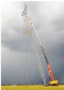
Primeiras torres da interligação - C1
