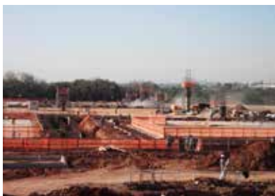
Construção do novo Terminal de Cargas
