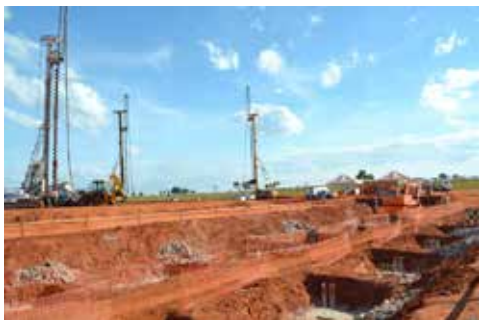
Obras civis da UFN III
