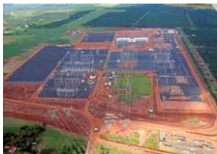
Vista aérea da SE Araraquara II
