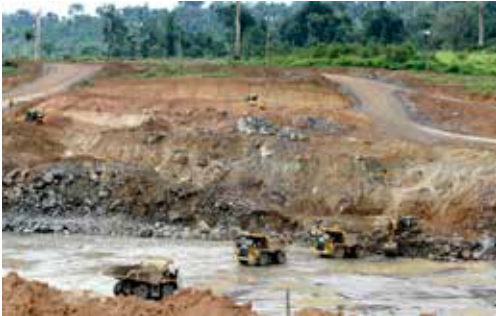
Escavações – canais de derivações
