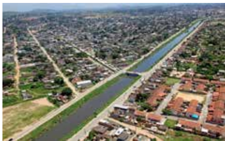
Desassoreamento do rio Botas e implantação de vias marginais – Belford Roxo
