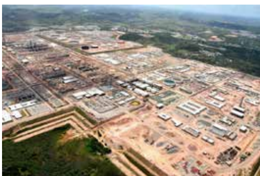
Instalações da Refinaria Abreu e Lima
