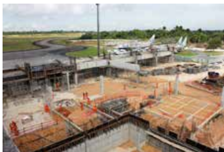
Reforma e ampliação do TPS
