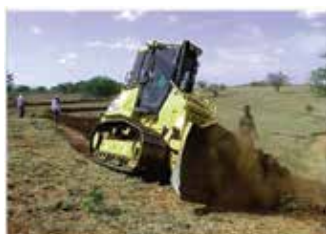
Construção de terraço agrícola para controle da erosão
