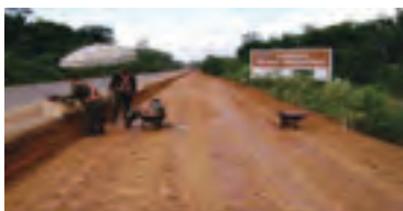
Regularização de subleito
