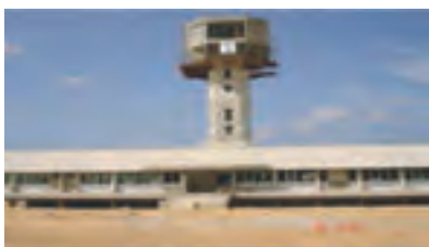
Construção Torre de Controle e TECA
