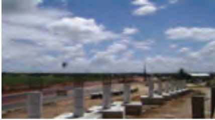
Execução do viaduto sobre linha férrea I
