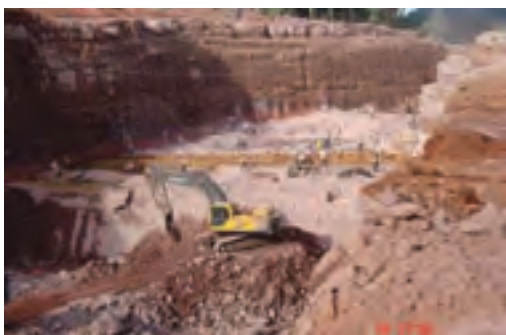
Vista da câmara de carga e tomada d'água
