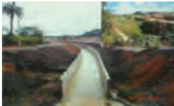
Macro drenagem em Bom Despacho
