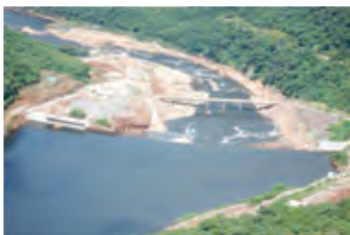
Vista da barragem à montante
