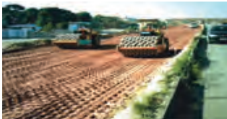
Execução de terraplenagem na pista nova – BR-101
