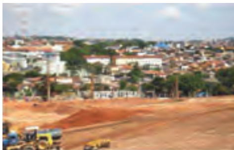
Vista geral das obras na Vila São José
