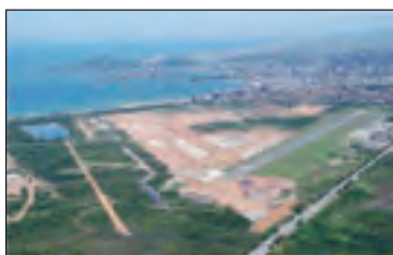
Construção novo terminal de passageiros
