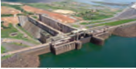
Obras da Eclusa 1
