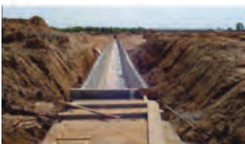
Obras de infra-estrutura em Vila Dique
