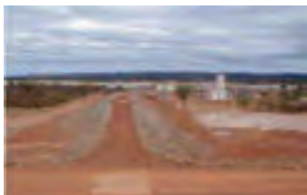
Acesso à estação de bombeamento principal
