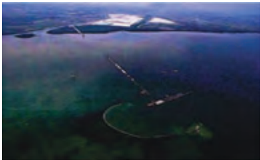
Porto de Itaguaí/RJ – Terminal da CSA em construção
