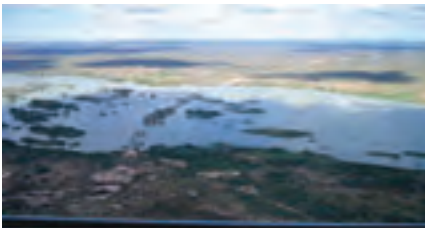
Região eixo aproveitamento hidrelétrico Pedra Branca
