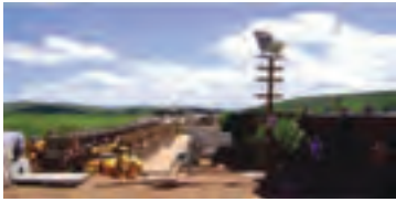
Execução da ponte sobre o Rio Amaraji – km 153,3
