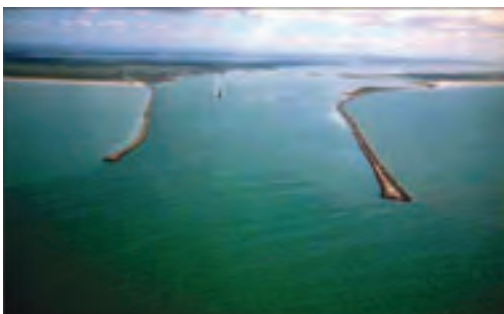
Entrada do canal de acesso interno do Porto de Rio Grande/RS
