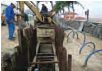
Obra em Itanhaém – Av. Mário Covas
