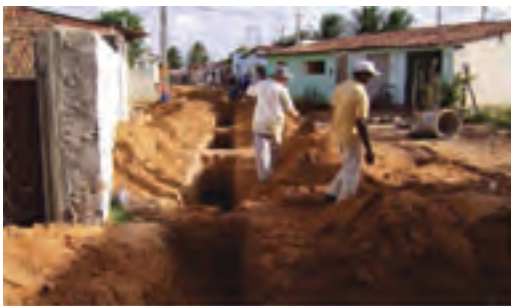
Obra no bairro de Nossa Senhora da Apresentação
