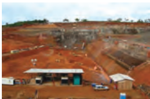
Vista geral das obras
