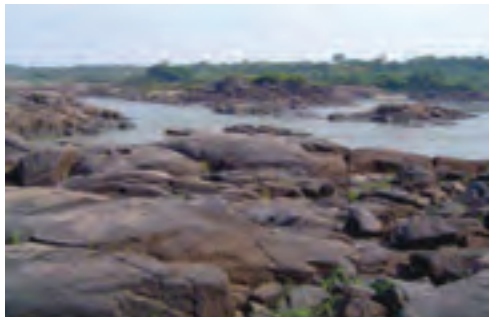
Vista local do eixo do futuro barramento
