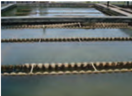
Filtros da ETA que será ampliada
