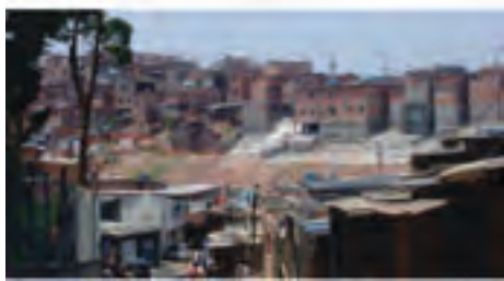
Obras de contenção
