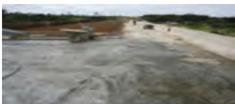
Ponte sobre o Riozinho das Arraias – 80% concluída
