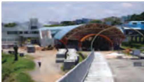
Estação Acesso Norte
