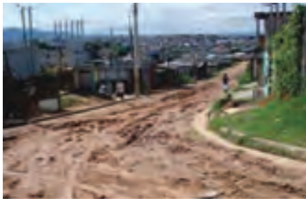
Obra de esgotamento sanitário em Guarulhos
