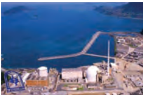
Vista geral das usinas
