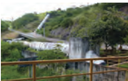
Adutora de água bruta
