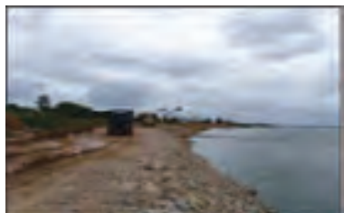
Contenção de erosão na margem do São Francisco
