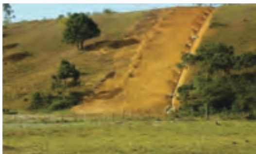
GASENE: Cabiúnas-Vitória – conclusão do enterramento do duto
