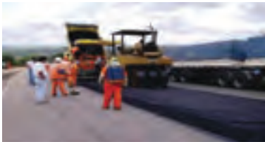
Execução de Binder – km 19,4
