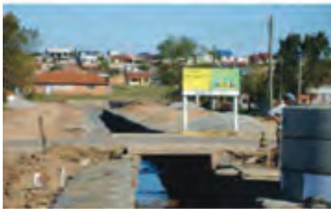
Obras na Vila Ecológica
