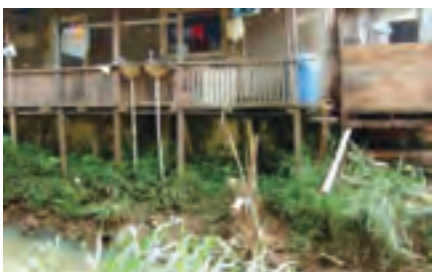
Lançamento irregular de esgotos no município
