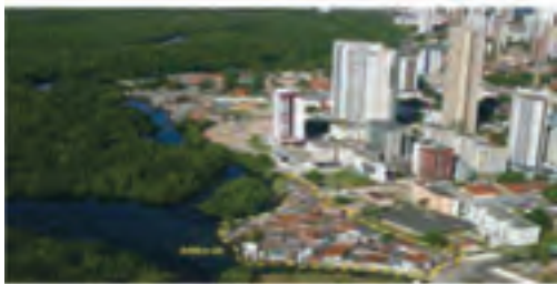
Vista geral da área de intervenção
