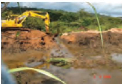
Remoção de solo mole km 40
