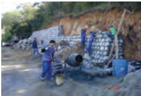
Obras de contenção de encosta
