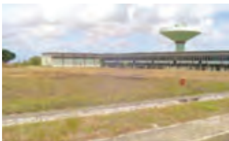
Área de expansão da ETA
