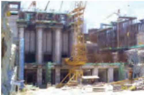
Vista da Casa de Força
