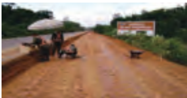
Regularização de subleito
