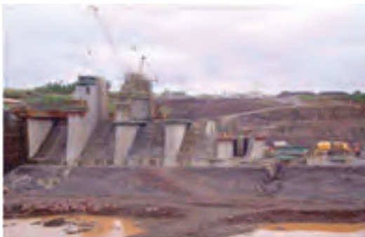
Vista do vertedouro
