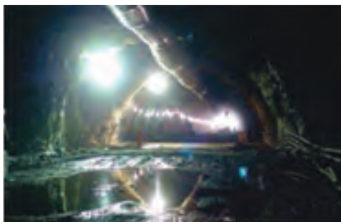
Vista interna do túnel 3
