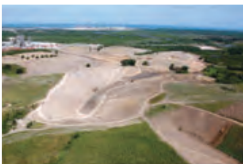
Refinaria Abreu e Lima – terraplanagem
