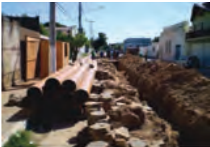
Execução da rede coletora – Microsistema B
