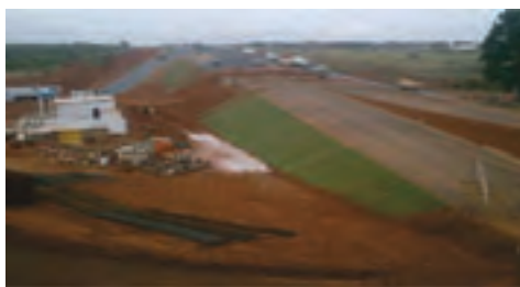
Execução de viaduto em Uberlândia
