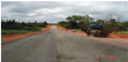
Tratamento Superficial Duplo (TSD) concluído – km 914,0
