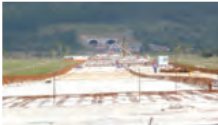
Túnel do Morro Alto – emboque norte
