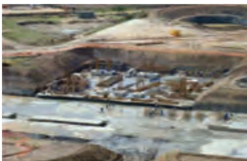
Vista aérea das obras
