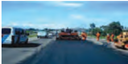
Execução de capa de rolamento
