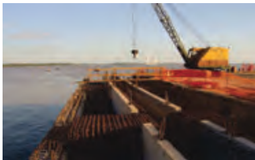
Alargamento do Cais Sul
