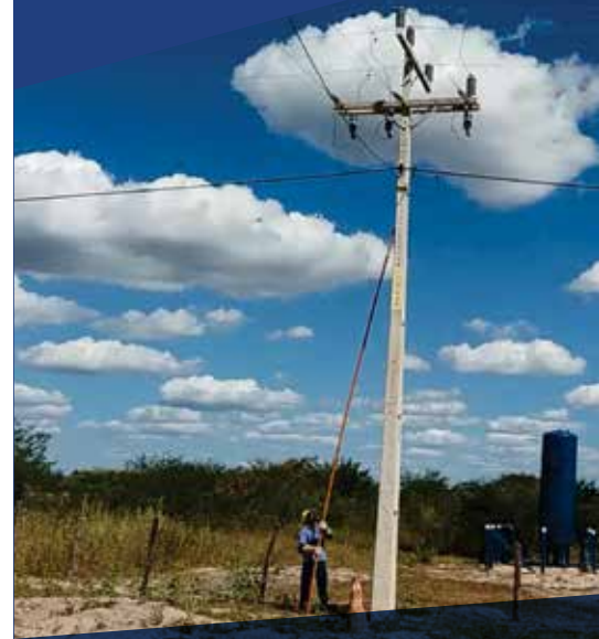
Momento da ligação da energia elétrica no assentamento Ponta D'água (BA)
