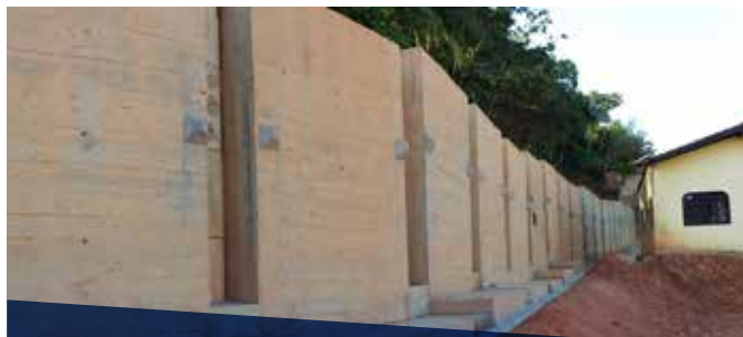
Contenção de encostas em Blumenau (SC)
