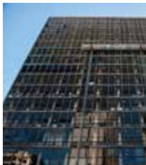
RESTAURAÇÃO DO PALÁCIO GUSTAVO CAPANEMA, RIO DE JANEIRO (RJ)
