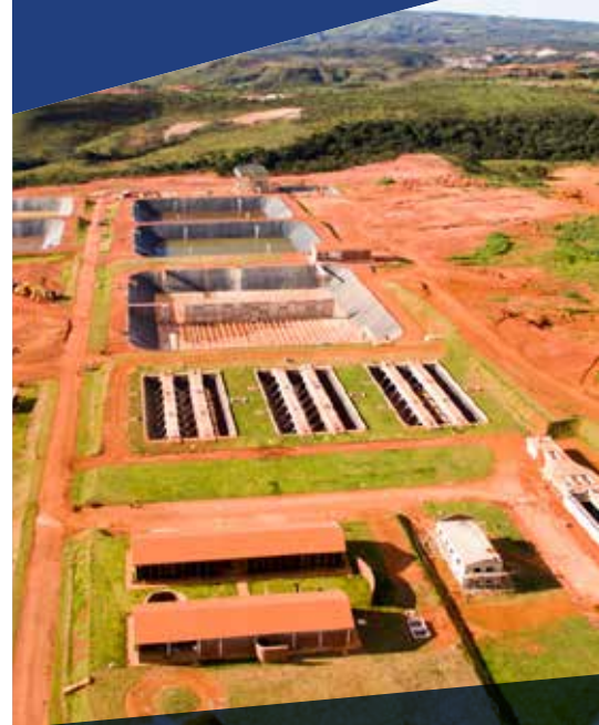
Implantação do Sistema Corumbá Sul (DF)
