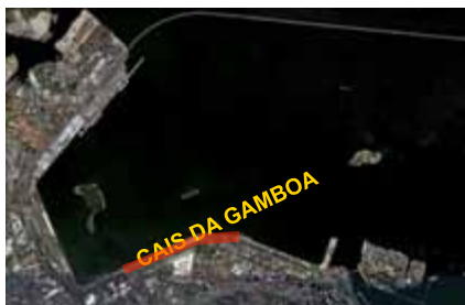
Vista aérea Porto do Rio
