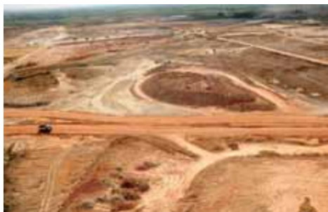
Refinaria Premium I – Terraplanagem
