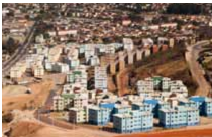
Produção de UH – obras de infraestrutura
