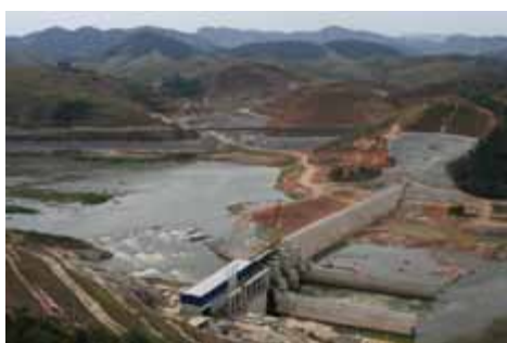
Visão Geral - Barragem e Vertedouro
