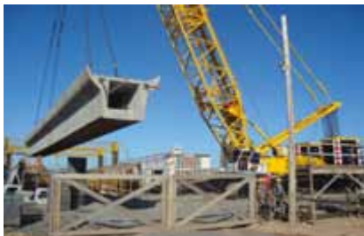
Execução do elevado
