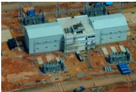
Estação Conversora Porto Velho
