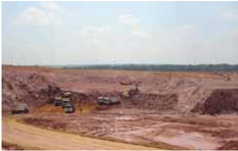
Área da Casa de Força – Escavações
