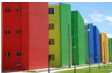
Construção de Unidades Habitacionais
