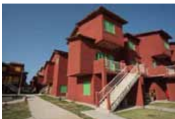
Unidades habitacionais do Terreno 1
