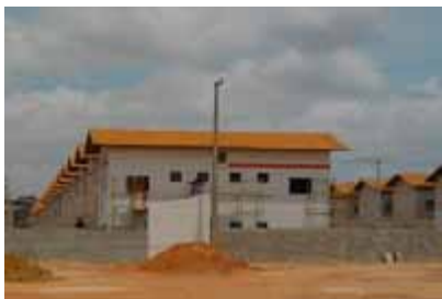
Conjunto habitacional em Jaderlândia
