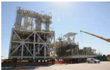
Plataforma P-55 - Módulos
