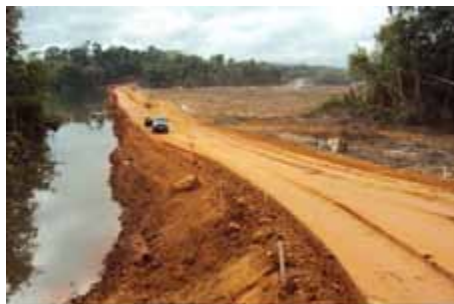
Construção da Ensecadeira
