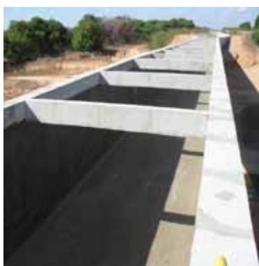
Trecho IV – Canal
