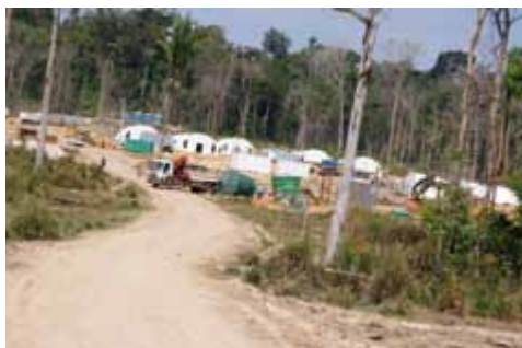
Visão Geral - canteiro de obras pioneiro
