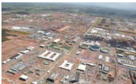
Refinaria Abreu e Lima – Vista geral das obras
