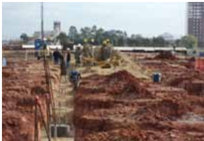
Construção do novo Terminal de Cargas
