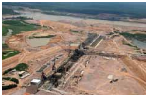
Casa de Força e Vertedouro – margem direita
