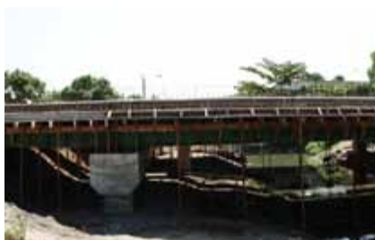
Construção da ponte José Romão
