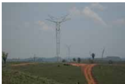
Primeiras torres da Interligação – C1
