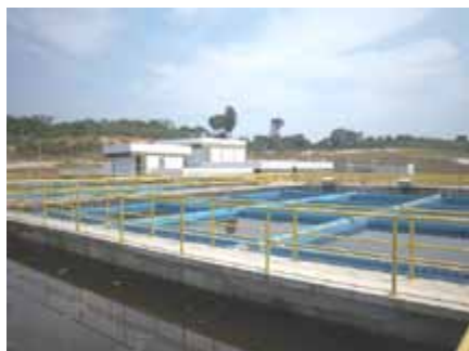
ETA COC - Castanheiras - decantadores
