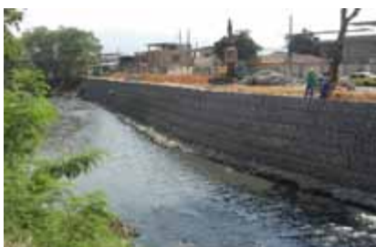
Estrutura em gabião – Rio Sarapuí – São João de Meriti
