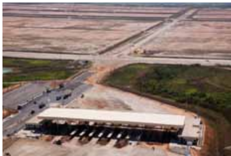
Instalações do COMPERJ
