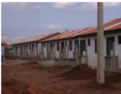
Construção de 85 UH no Jardim Marisa
