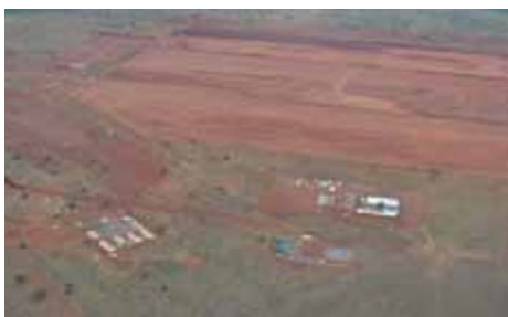
UFN III – Obra de Terraplanagem
