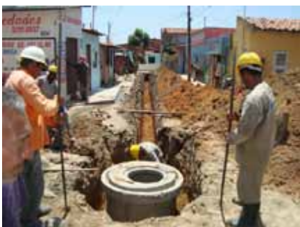
Assentamento de rede coletora no Bairro Serrinha
