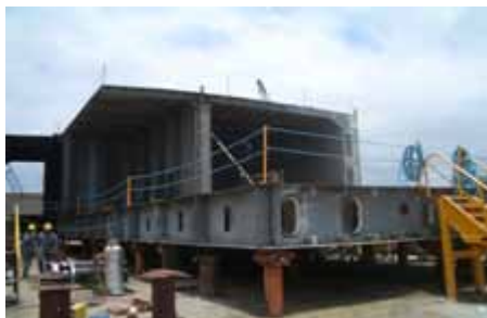
Estaleiro Superpesa – Montagem dos Blocos
