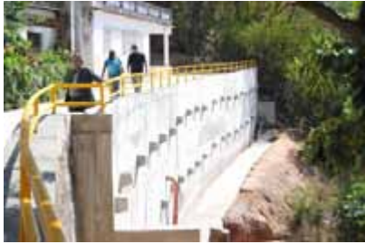
Contenção de encosta no Bairro Cruzamento
