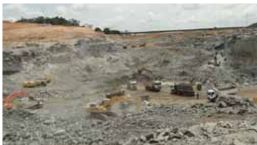
Escavações em Rocha – Casa de Força
