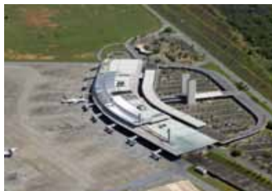
Reforma e modernização do TPS
