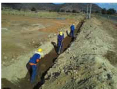
Implementação da adutora
