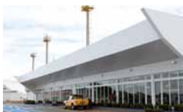
Aeroporto de Goiânia – módulo em operação
