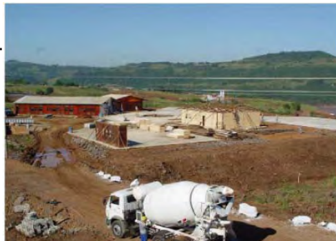
Vista canteiro de obras
