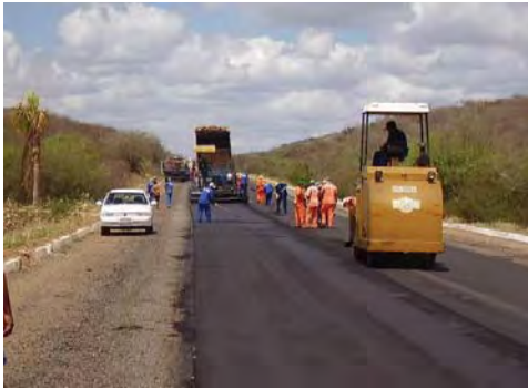
Restauração em execução
