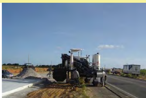
Máquina extrusora para execução de drenagem
