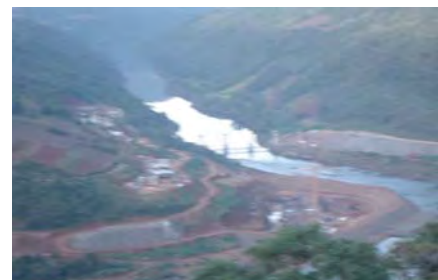
Vista geral das obras
