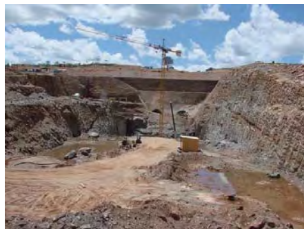
Escavações e obras da casa de força
