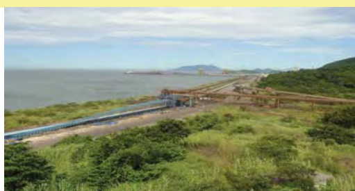
Vista do canal de acesso ao Porto
