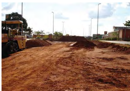
Terraplenagem nas vias marginais de Uberlândia
