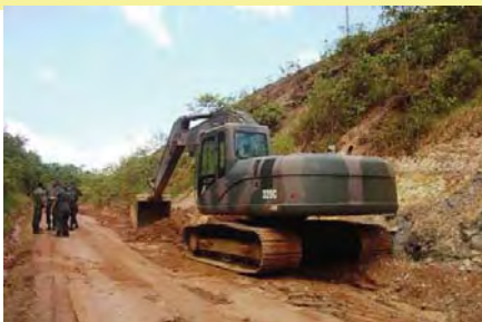
Terraplenagem km 99 - Santarém - Rurópolis
