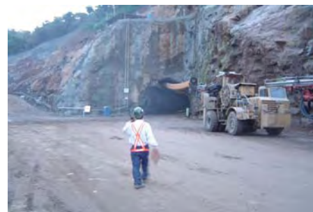
Escavação do túnel de adução
