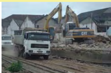
Demolição de armazém 28
