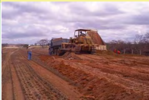
Terraplenagem em Missão Velha/CE
