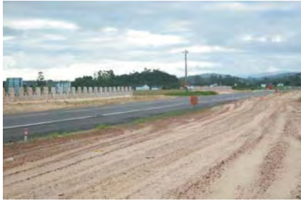
Sub-base e muro de contenção no Km 455
