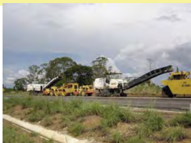
Equipamentos na restauração – km 15
