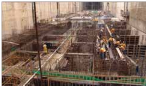
Eclusa 1 – Vista geral dos trabalhos na linha B
