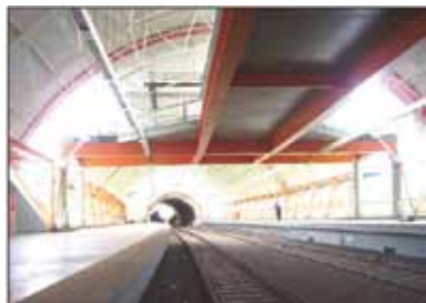
Estação Acesso Norte
