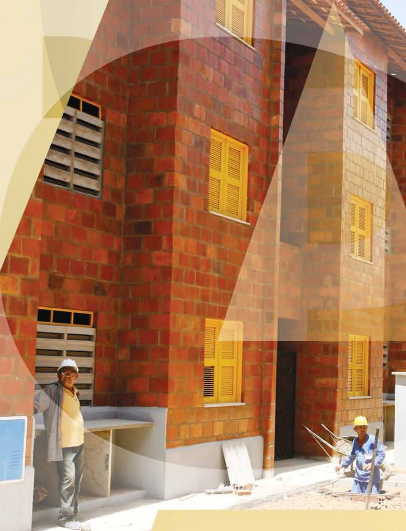
Conjunto Habitacional - Bairro Bom Jardim - Rio Maranguapinho • CE
