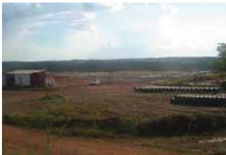
Canteiro de Obras
