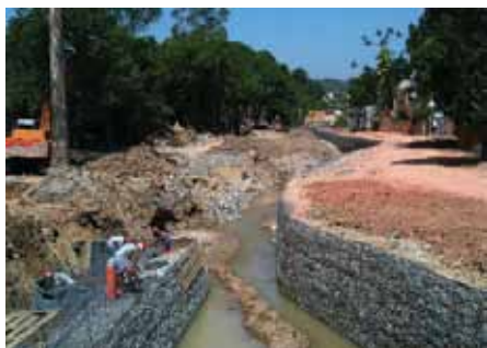
Retificação do rio Areal na Comunidade Entre Rios
