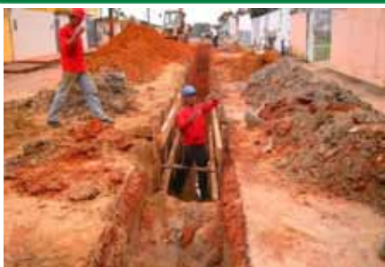
Rede coletora em execução
