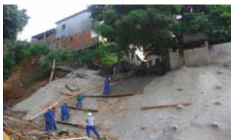
Contenção de encosta no Bairro Cruzamento
