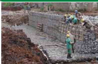
Canalização de córrego na área Cocaia I
