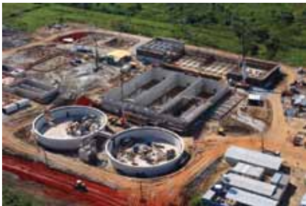
Construção da ETE Bonsucesso
