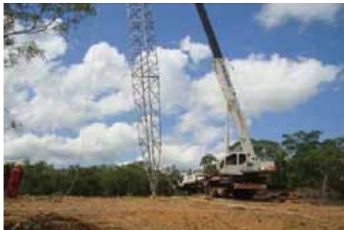
Torre estaiada içada
