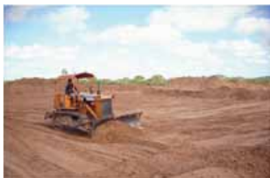
Construção do aterro sanitário em Ibimirim/PE
