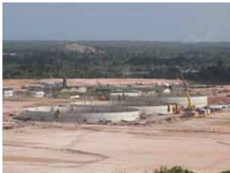
Montagem dos tanques de água bruta
