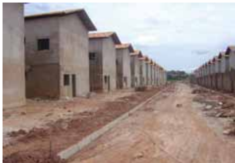
Conjunto Habitacional em Jaderlândia
