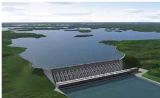
Casa de Força Principal
