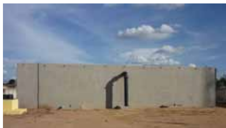
Reservatório apoiado – Raiar do Sol
