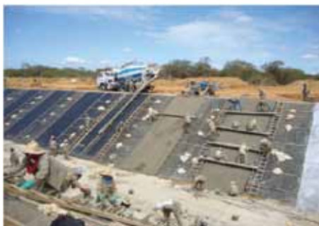
Canal Principal da Etapa 2
