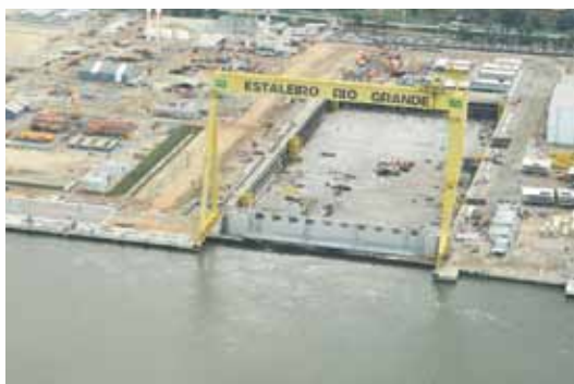
Estaleiro Rio Grande – Porta Batel em funcionamento
