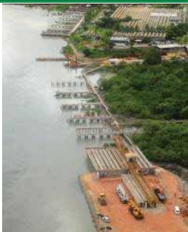
Vigamento do trecho elevado do Sistema Viário
