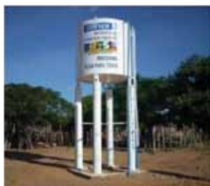
Reservatório elevado para abastecimento de água no povoado de Carneiro, em Xique-Xique/BA
