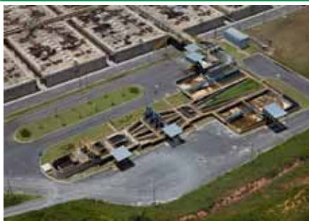
Tratamento preliminar ETE Onça
