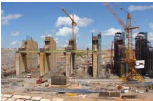
Vista Jusante do Vertedouro Principal
