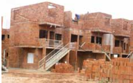
Construção de 264 UH verticais - Terreno 1
