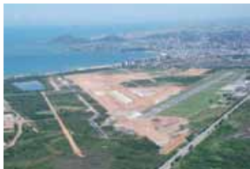
Construção novo terminal de passageiros
