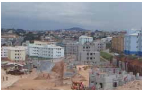
Vista parcial das unidades habitacionais na Vila São José
