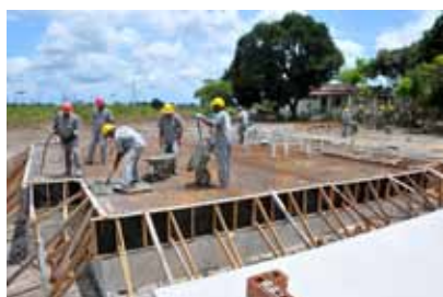
Construção de 400 UH em Novo Redentor – Camaragibe
