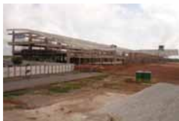
Construção novo terminal de passageiros
