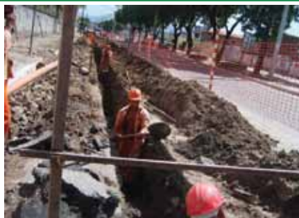
Assentamento de rede na Av. Osório de Paiva – Bacia SD-6
