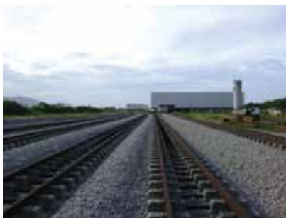
Via Permanente e Centro de Manutenção
