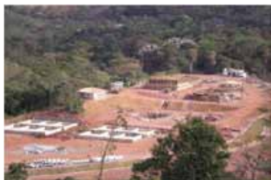
Construção da ETE em Itabirito/MG
