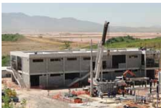
Construção da subestação transformadora
