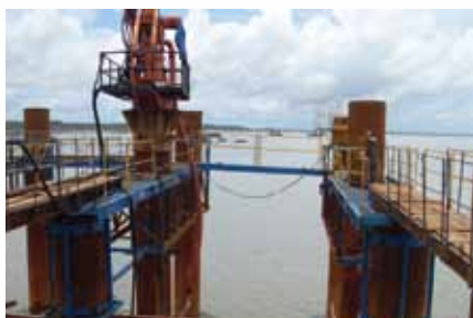
Cravação e concretagem das estacas do Berço 100
