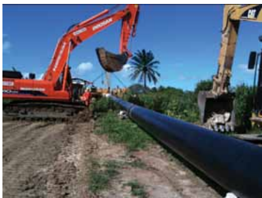
Obras no gasoduto
