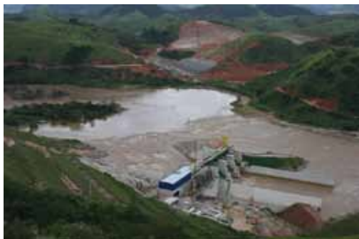
Vista do Vertedouro
