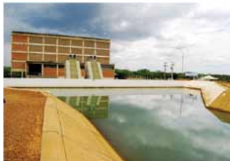
Estação de Bombeamento
