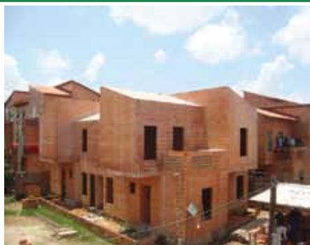
Construção de UH
