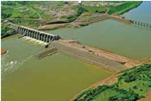
Vertedouro e Barragem Principal
