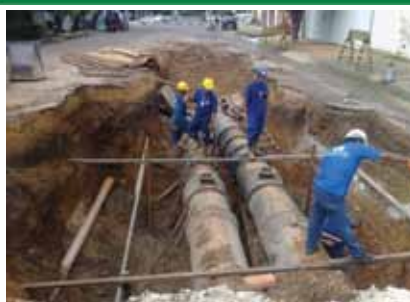
Adução em execução
