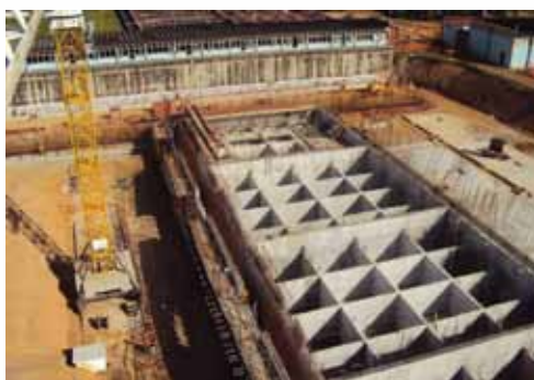
Ampliação da ETA Gramame
