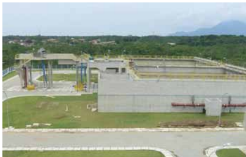
ETE de Peruíbe
