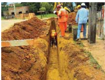
Rede coletora em execução
