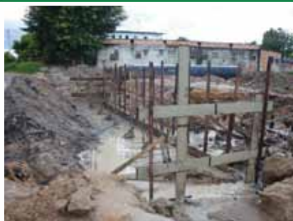
Execução das fundações da Ponte José Romão
