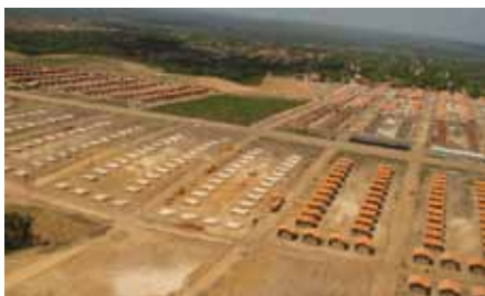
Construção de unidades habitacionais - UH
