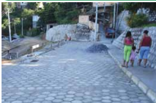
Terraplenagem e pavimentação no Alto da Caieira
