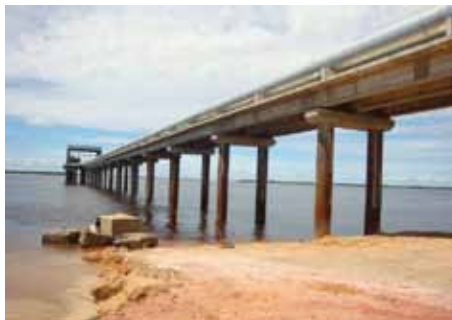
Ponte para adução de água do Rio Negro
