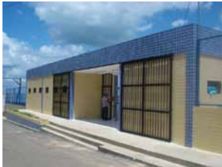
Estação Escada ampliada e recuperada
